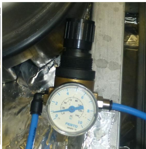
Figura 74 – Regulador de pressão
