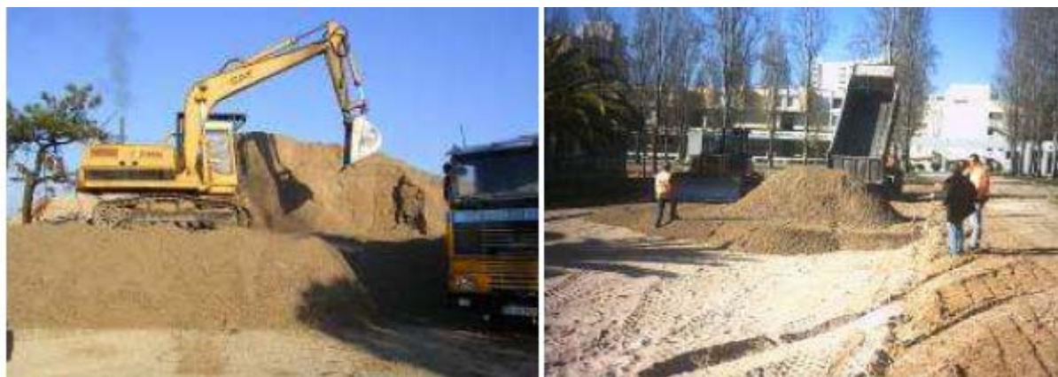
Figura 17 - Carregamento e colocação dos RCD sobre a camada de areia (extraído de Martinho e Gonçalves, 2008)
