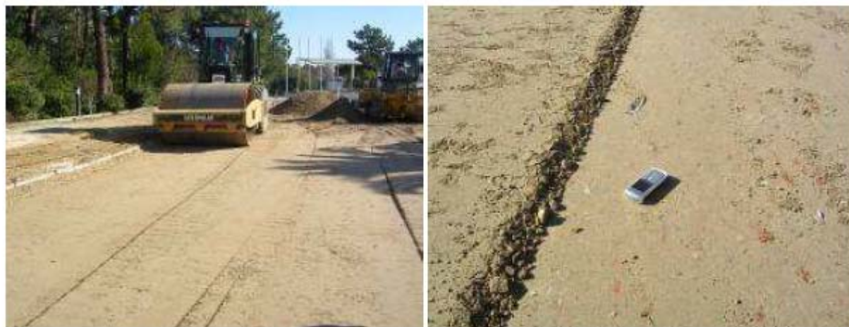
Figura 18 - Compactação e aspecto final da camada
