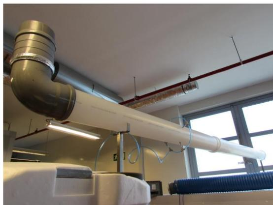
**Figura 5. 8** – Condutas PVC para a rede de extração
