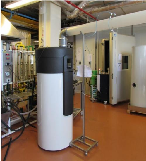
**Figura 5.11** – Bomba de calor com conduta de extração instalada
