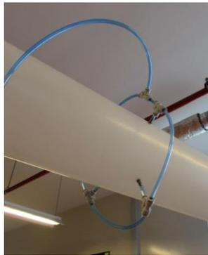
**Figura 5. 6** – Pontos de medição da perda de carga
