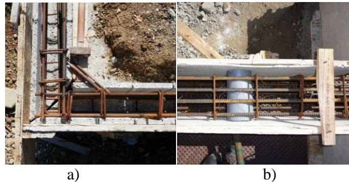
Figura 5 - Colocação de armaduras nas vigas; a) Alvenaria Estrutural; b) Betão armado
