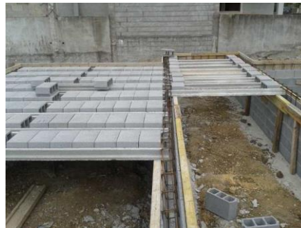
Figura 6 – Laje aligeirada com blocos de betão.
