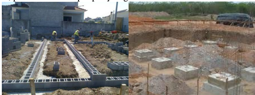
Figura 3 – Sapatas de fundação do sistema em alvenaria estrutural (esquerda) e em betão armado (direita)
