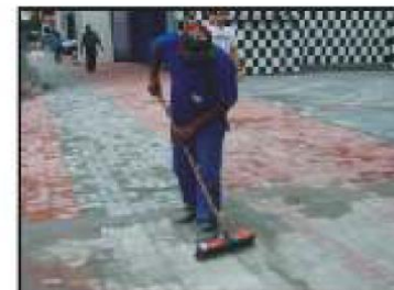
Limpeza e abertura ao tráfego.
