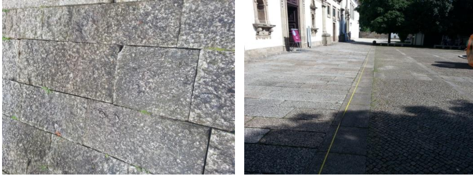
Figura 28 - Aspeto do pavimento no trecho em lajeado de granito
