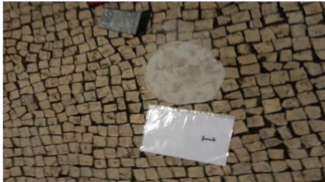
Figura 47 - Ensaio de mancha de areia e padrão de assentamento disforme no trecho em cubos de calcário
