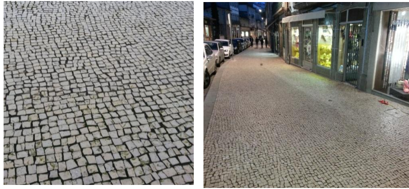
Figura 20 - Aspeto do pavimento no trecho em cubo calcário
