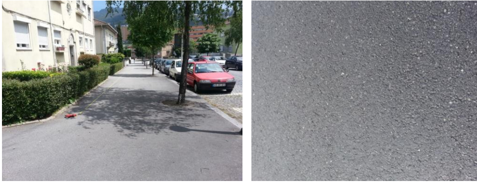
Figura 22 - Aspeto do pavimento no trecho em betuminoso (Guimarães)
