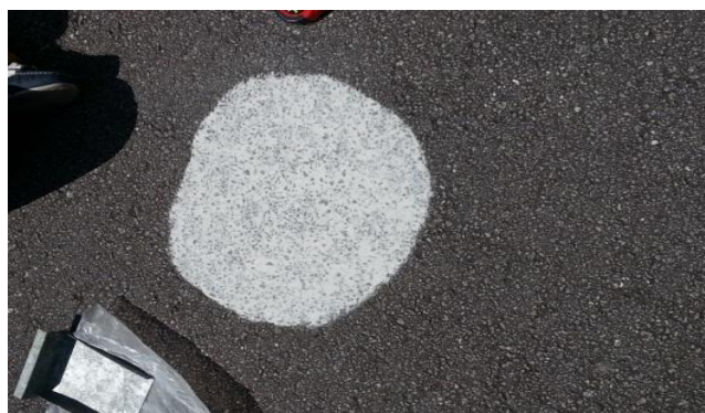
Figura 50 - Ensaio da Mancha de areia no trecho em betuminoso (Guimarães)
