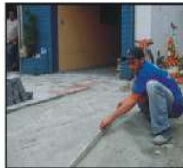
Espalhamento e nivelamento da areia de assentamento.
