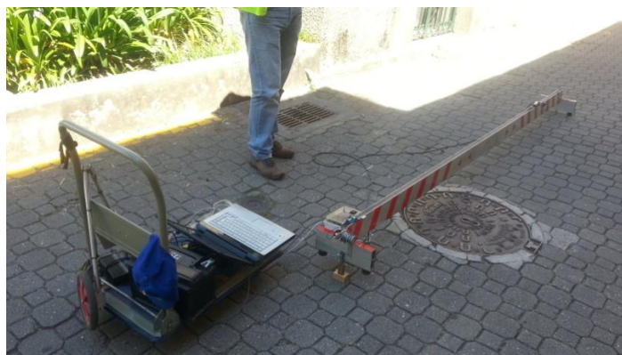
Figura 95 - Zona irregular devido a uma tampa de águas pluviais
