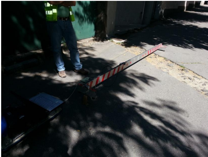
Figura 87 - Zona irregular devido a deformações no trecho
