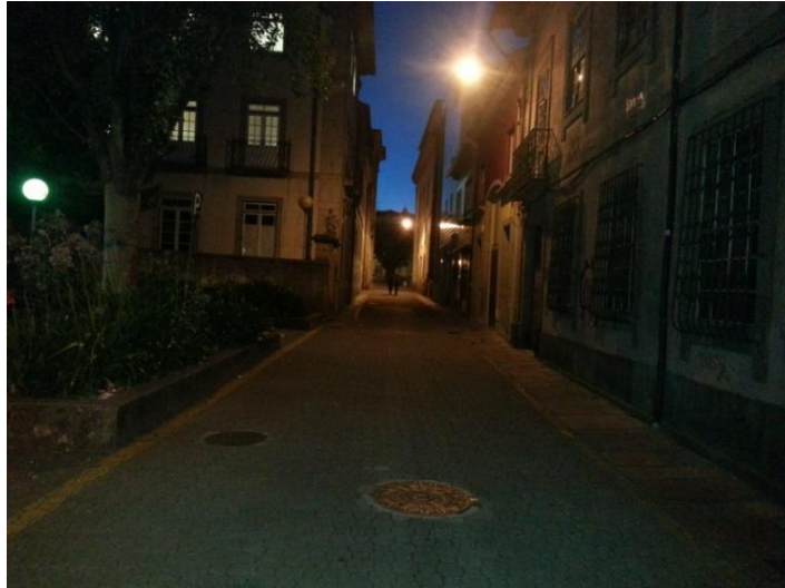
Figura 112 - Iluminação presente no trecho em blocos de betão
