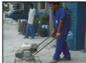
Compactação inicial, revisão, ajustes, espalhamento da areia, rejuntamento e compactação final.
