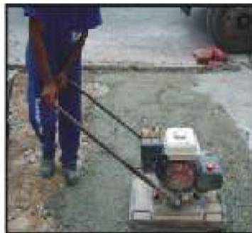
Instalação das contenções laterais, nivelamento e compactação da base.
