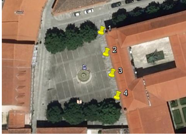
Figura 56 - Localização dos pontos de ensaio no trecho em Lajeado de Granito
