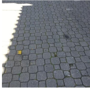
Figura 30 - Aspeto do pavimento no trecho em blocos de betão
