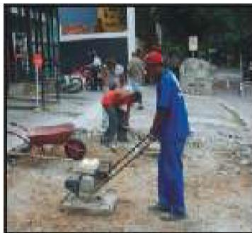
Nivelamento e compactação da fundação.
