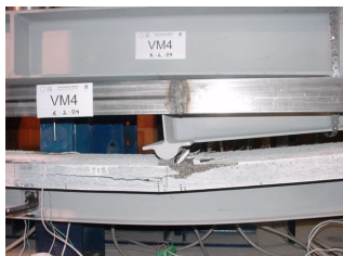
Figura 5 – Rotura de VM4
