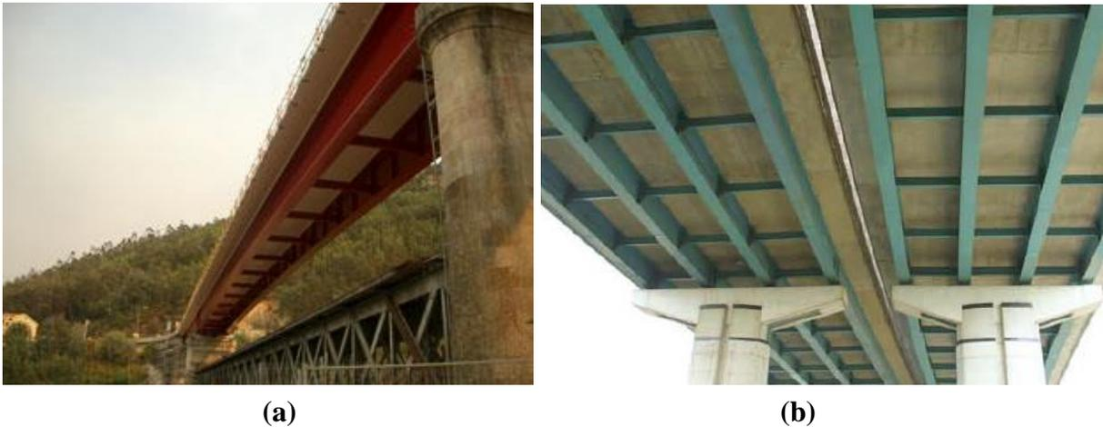
**Figura 2.22** – Pontes mistas com, a) viga dupla e b) Múltiplas vigas [13].
