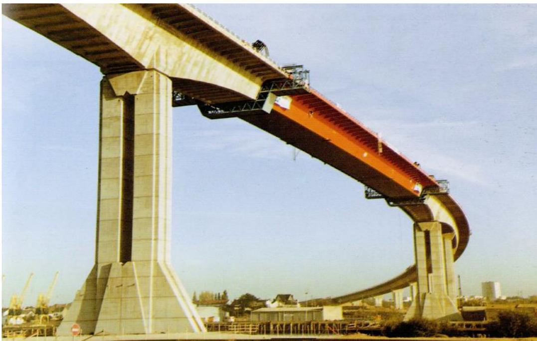
**Figura 2.24** – Ponte com secção em caixão [18].
