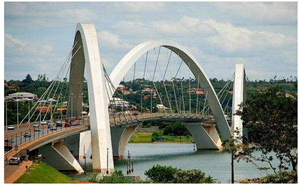
**Figura 2.8** – Ponte “JUSCELINO KUBITSCHEK”, atirantada com arco [6].
