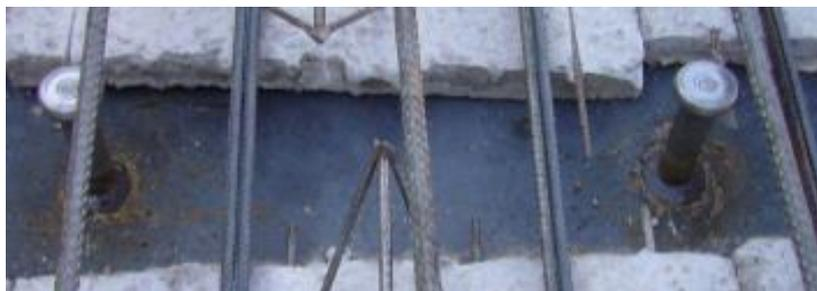
**Figura 2.11** – Conectores metálicos tipo “headed stud” [10].
