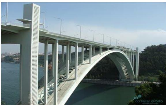
**Figura 2.3** – Ponte da Arrábida, Porto, em arco, construída em betão armado pré-esforçado [3].
