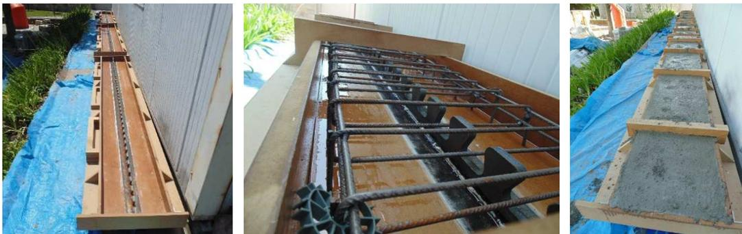
Figura 9. Processo de montagem da cofragem, da armadura e betonagem da laje.
