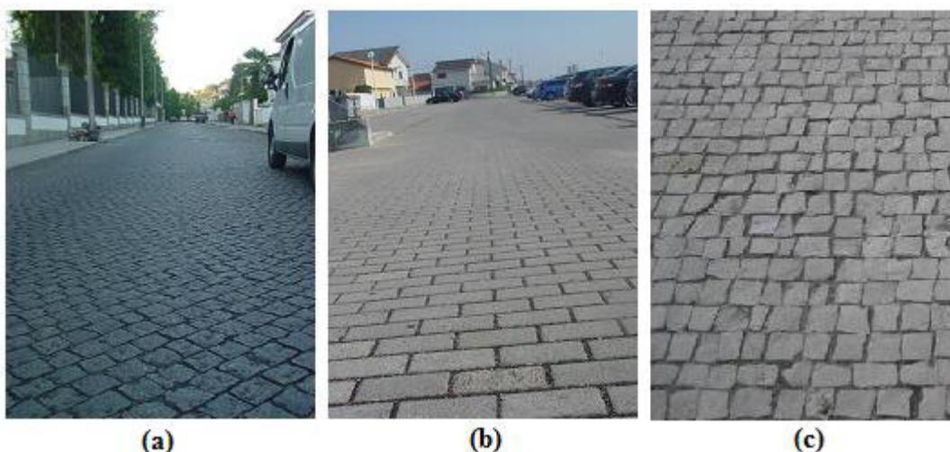
Figura 17 – Exemplos de pavimentos em cubos de granito (a), blocos de cimento (b) e cubos de calcário (c) (<http://www.alvestone.com>)
