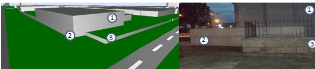
Figura 68 - Muros e pavilhão polidesportivo (modelo esq. versus realidade dir.)
