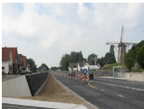
Figura 32 - Estrada após construção [26]
