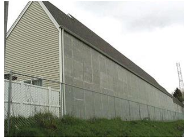
Figura 36 - Aspeto exterior das habitações [22]
