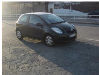
Figura 51 - Estado de considerável degradação do pavimento
