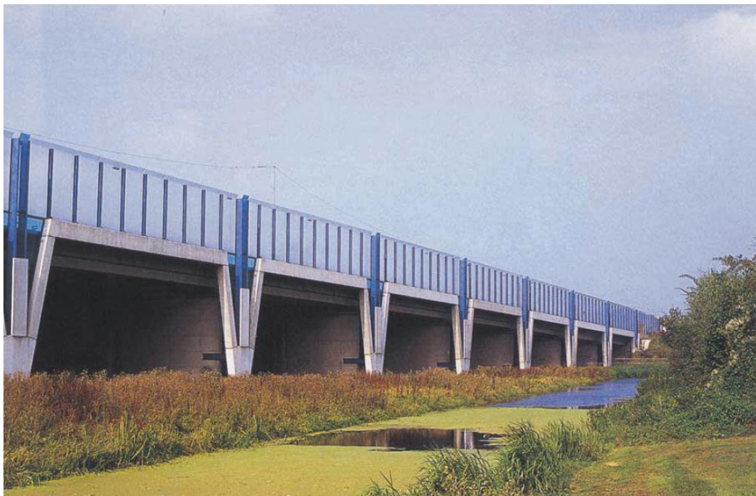
Figura 5.13 - Barreira transparente que mitiga o ruído, e ao mesmo tempo aumenta o interesse visual do viaduto, [27]
