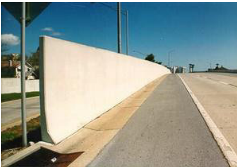
Figura 5.7 - Barreira de betão betonado in situ, [25]
