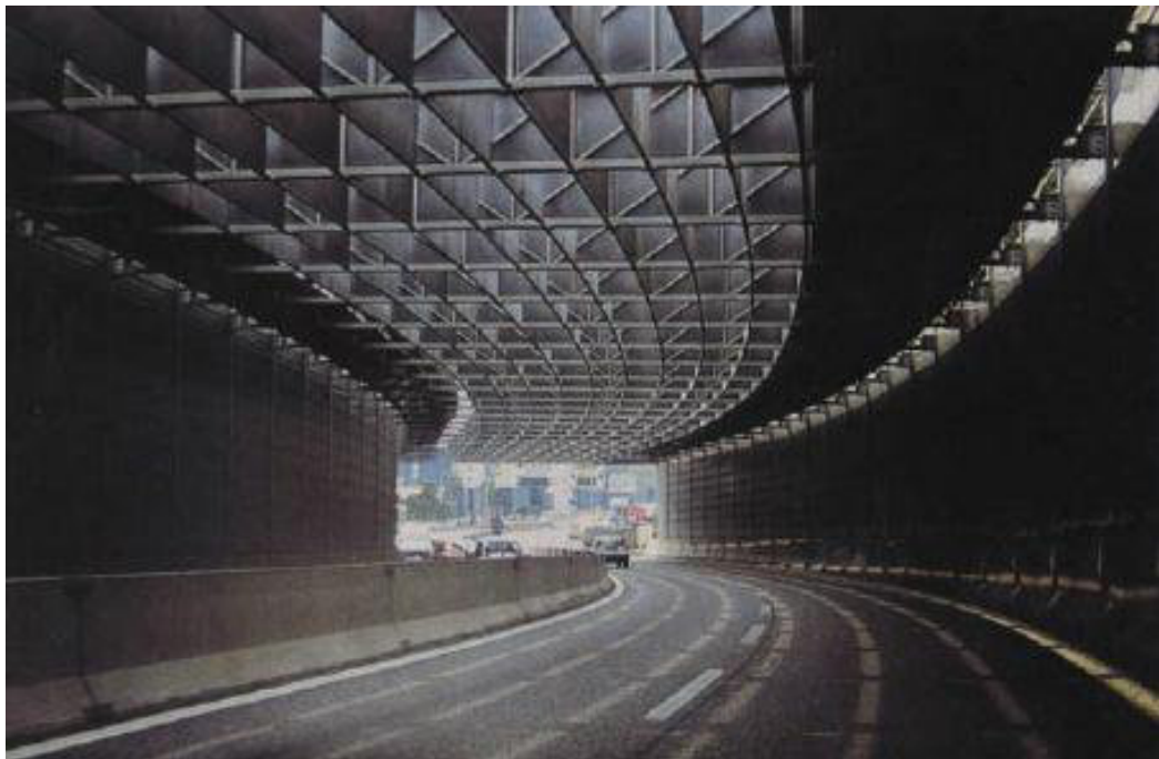
Figura 5.26 - Vista interior do túnel em Génova, que contem painéis absorventes no tecto, [27]
