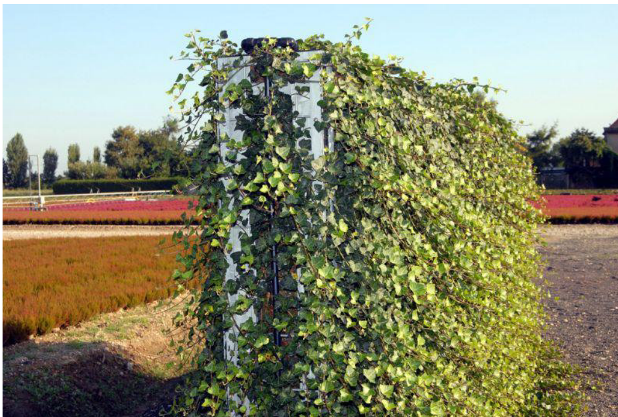
Figura 5.17 - Exemplo de uma bio-barreira em caixa de solo plantada com hera para se inserir melhor no ambiente circundante, [30]
