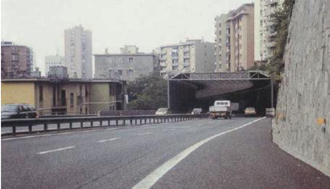
Figura 5.25 - Aproximação ao túnel em Génova, [27]
