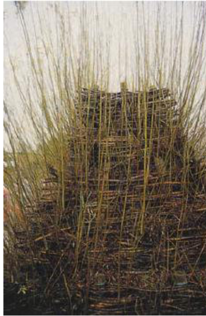
Figura 5.18 - Barreira de rebentos de salgueiro entrelaçados entre si, [27]
