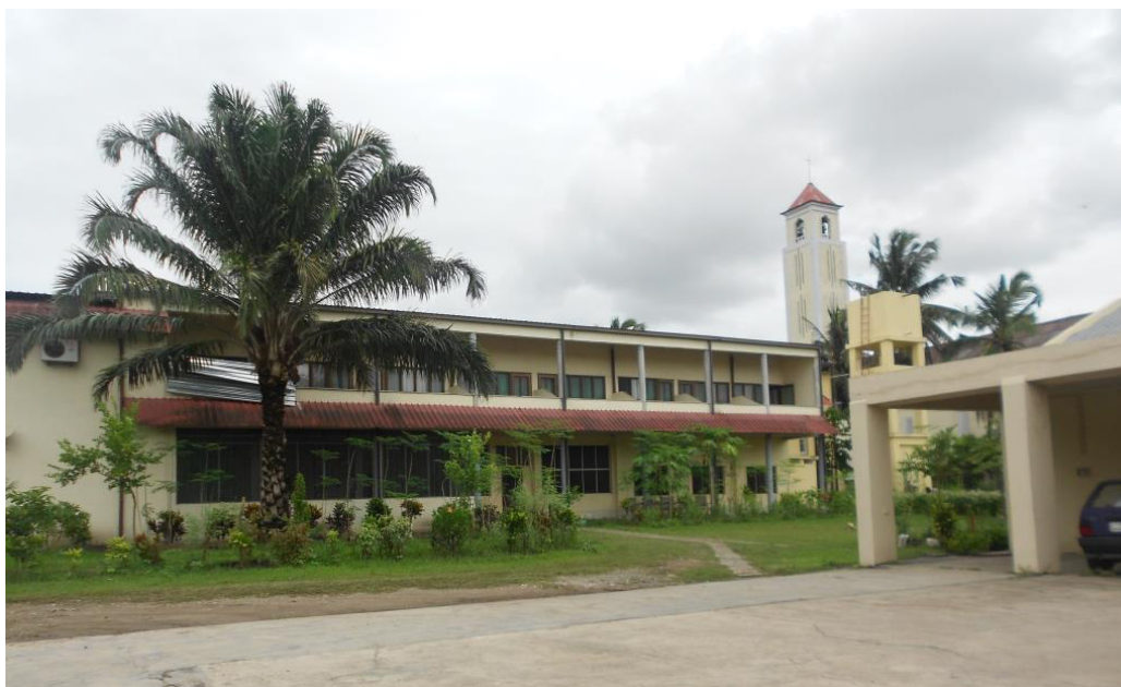
Fig. 7 - Casa Provincial de Quelimane
