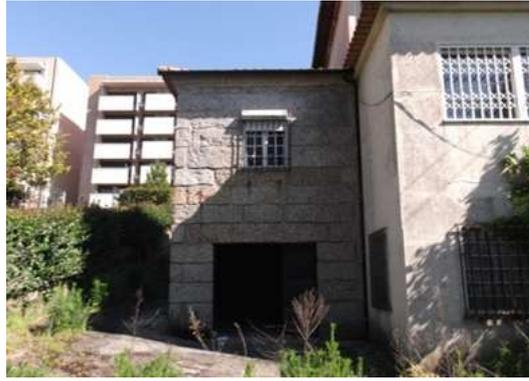
Figura 3.2: Vista do alçado sul com o anexo em granito do lado esquerdo em contraste com a construção original do lado direito
