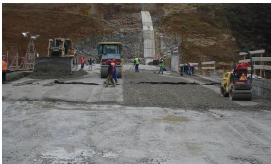
Figura 3.3 – Aplicação betão compactado por cilindros (BCC) numa barragem (Ribeiro, 2004)
