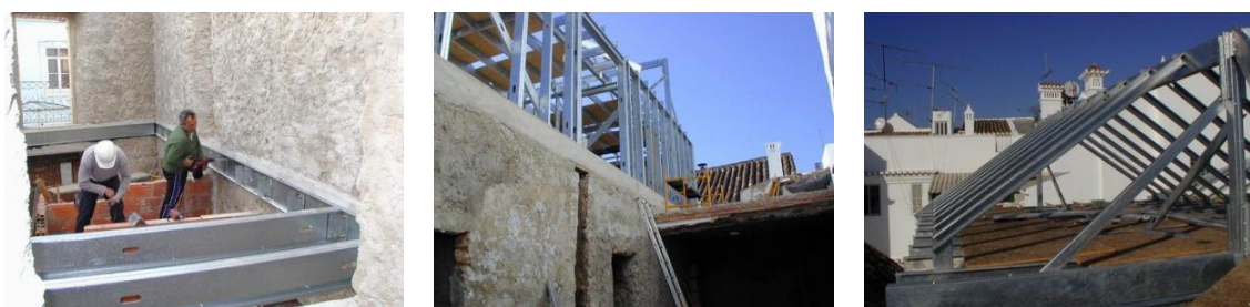
Figura 2 – Exemplo de uma operação de reabilitação utilizando LSF (Fonte: www.gestedi.pt )
