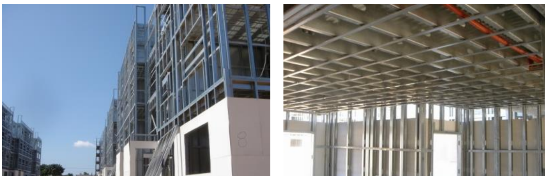
Figura 1 – Exemplos de construção de edifícios residenciais com LSF (Fonte: www.gestedi.pt )
