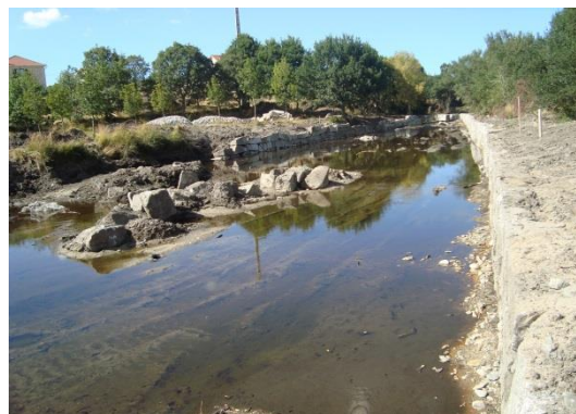
Fig. 2 – Obras de regularização do rio Cávado em Montalegre.
