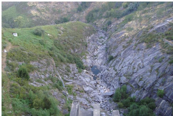
Fig. 27 – Troço do rio Rabagão, a jusante da barragem de Venda Nova.
