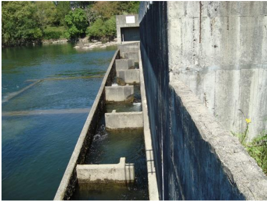
Fig. 13 – Escada para peixes na mini-hídrica da Ponte do Bico. Fonte: Foto tirada pelo autor, em maio de 2013.
