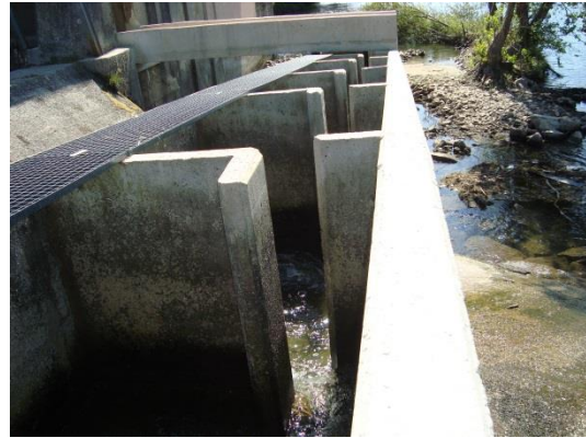
Fig. 14 – Escada para peixes na represa da fábrica de papel em Medros. Fonte: Foto tirada pelo autor, em julho de 2013.
