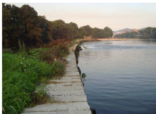
Fig. 12 – Açude no rio Cávado, em Barcelos.
