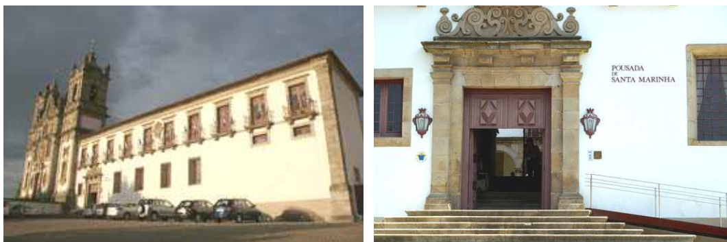
Figura 3.4 Vista parcial da fachada poente e entrada principal da Pousada Sta. Marinha
