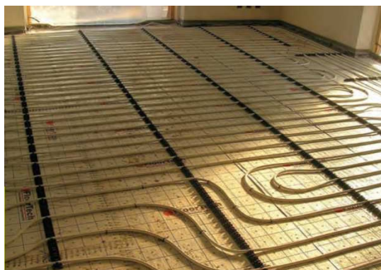
Figura 2.18 Colocação de tubos de polietileno reticulado (Santos, 2008)
