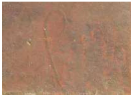
Figura 402 Fotografia de uma das marcas de "rabo de peixe" existente em alguns elementos do lastro do aqueduto. (UAUM).
