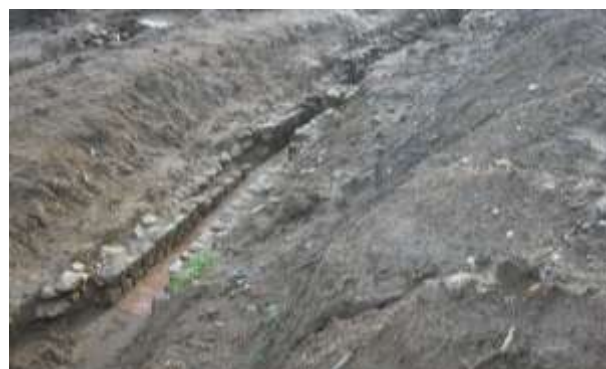
Figura 398 Fotografia em panorâmica do aqueduto de Gualtar UE0003 (UAUM).
