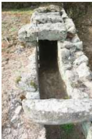
Figura 386 Fotografia em perspetiva geral do aqueduto (UAUM).
