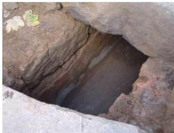
Figura 387 Fotografia de pormenor onde se vê o revestimento em opus signinum nas paredes e no lastro. (UAUM).
