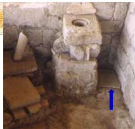
Figura 264 Fotografia da canalização D (MDDS).
