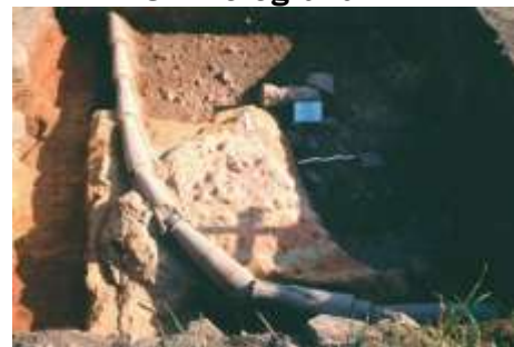
Figura 50 Fotografia da canalização UE0598 (MDDS).
