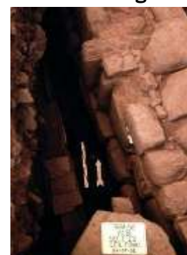
Figura 81 Fotografia com a canalização UE0877 (MDDS).
