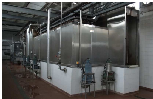
Fig. 3. 6 - Túnel de escalda vertical.
