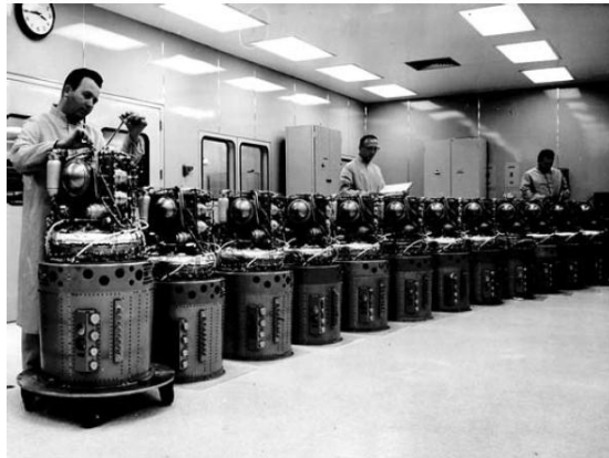
Figura 2.7 Montagem dos sistemas das FC pela Pratt & Whitney Aircraft engineers ( UTC Fuel Cells).
