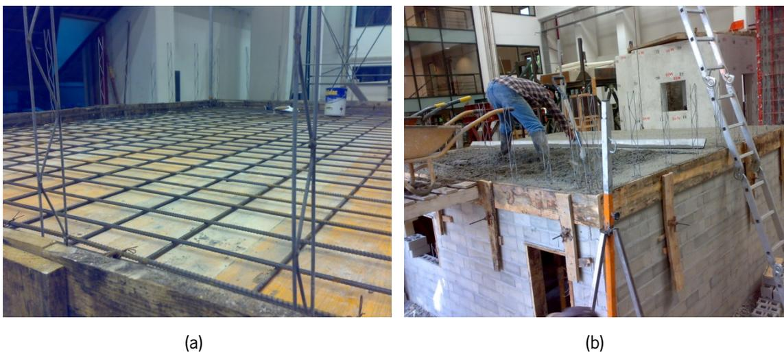
Figura 4.19 – Laje 1º Piso: (a) colocação da armadura; (b) betonagem.
