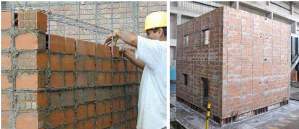
Figura 1.23 – Modelos com soluções inovadoras de alvenaria armada à escala reduzida em tijolo (Adell, 2010).
