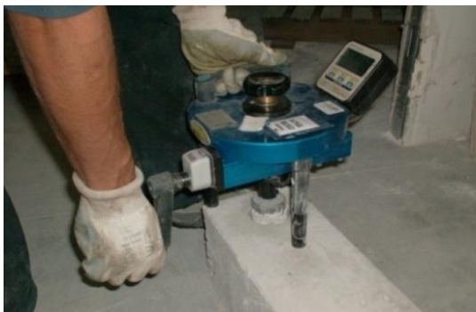
Figura 5. Execução do ensaio de pull-out
