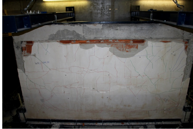
Figura 10 : Fendas e dano típicos para paredes armadas após ensaio no plano e fora do plano.
