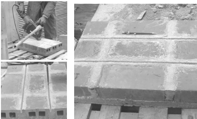
Figura 10. Realização de entalhes no betão.
