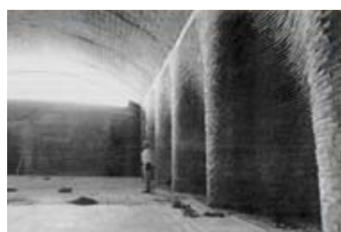
Figura 4. Vista do interior de um armazém em alvenaria cerâmica.
