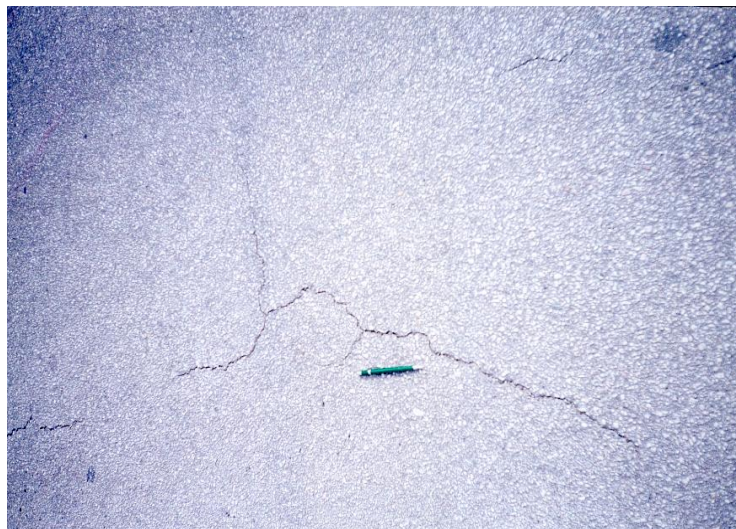
Figura 2.5 – Trinca isolada
