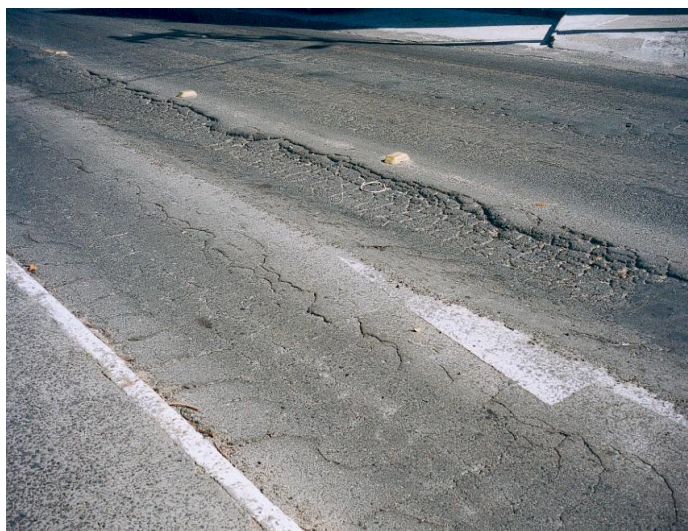
Figura 2.8 – Afundamento
