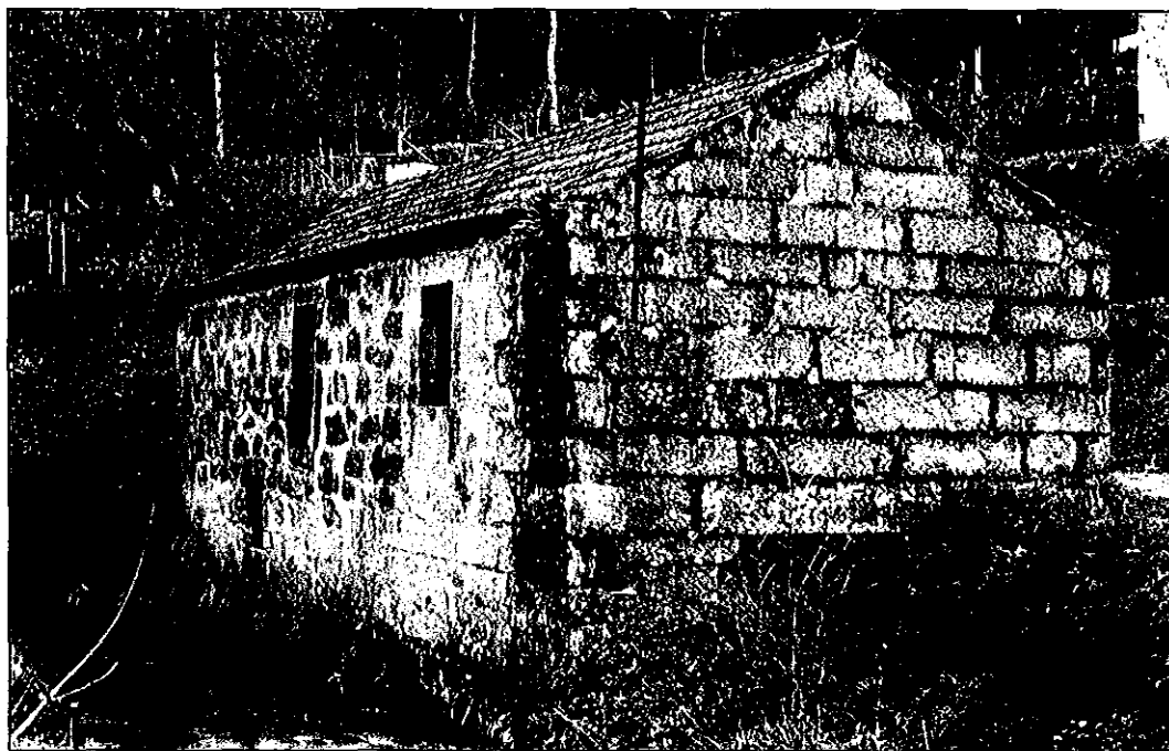
1 Aspecto do edifício da serra hidráulica de Pereiras, no rio Leça.
