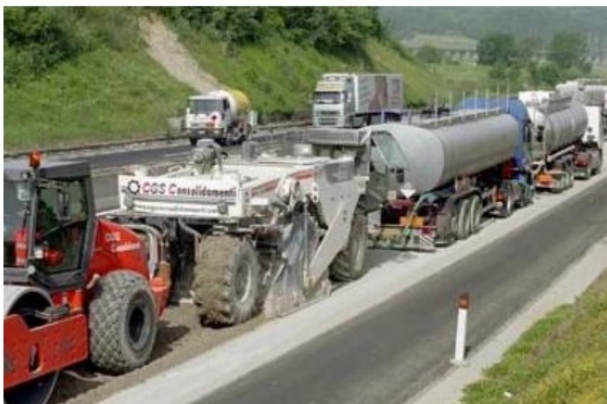
Figura 5 - “Comboio” de reciclagem *in situ* a frio (Wirtgen, 2009)
