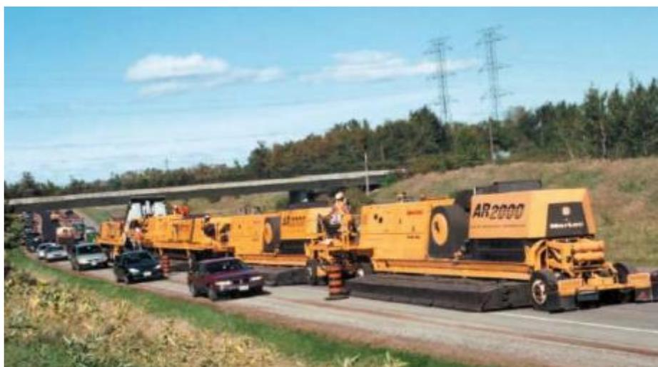
Figura 3 - Pré-aquecedores utilizados na reciclagem in situ a quente (Cunha, 2010)
