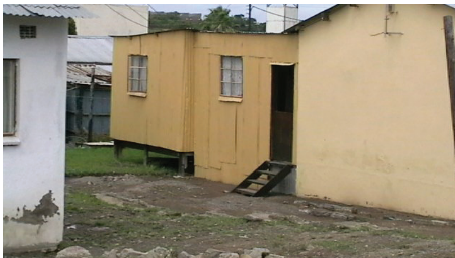
Figura 8. Modificação da habitação, elevada para evitar a inundação da estrutura
