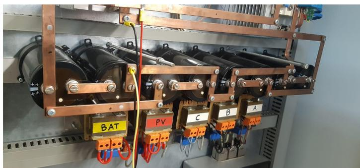
**Figure 5.19:** Bobinas de acoplamento à rede elétrica.
