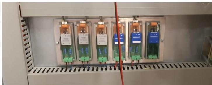
**Figure 5.4:** Montagem dos sensores de tensão junto às entradas do sistema
