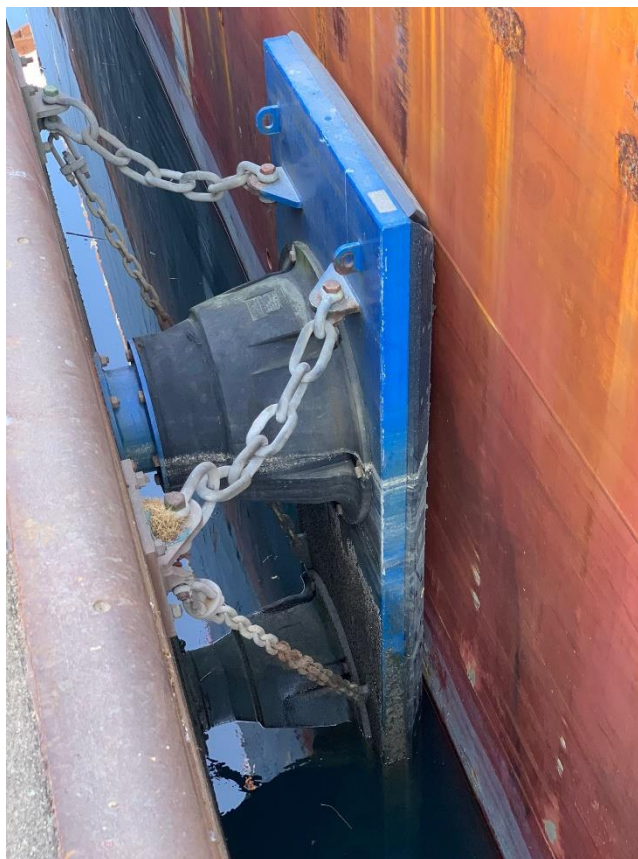
Figura 40 - Defesa SPC 800 G2.7. Registo realizado no dia 27 do fevereiro de 2023, após visita ao local.
