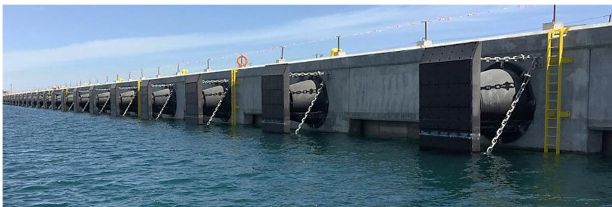
Figura 6 - Sistema de defensas cónicas (SUNHELM, 2023).
