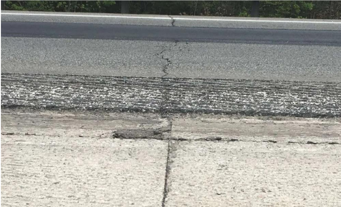
Figura 6 – Exemplo de um pavimento semirrígido (adaptado de Walbeck e Horan, 2019)
