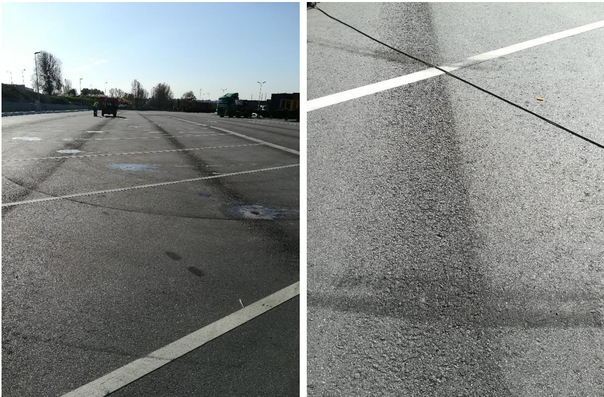
Figura 9 – Efeito da aplicação de esforços de torção com veículos pesados na zona 1 do pavimento com maior porosidade
