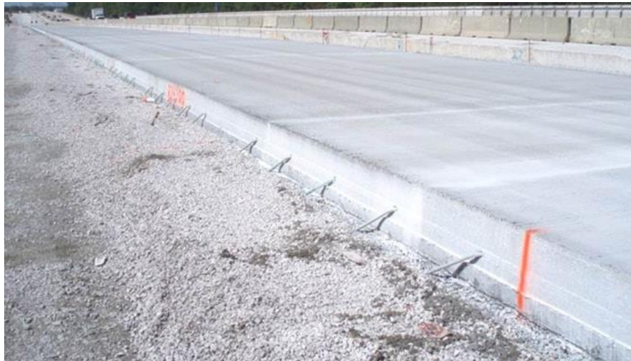
Figura 3 – Exemplo de um pavimento rígido durante a sua construção (Hamakareem, 2023)
