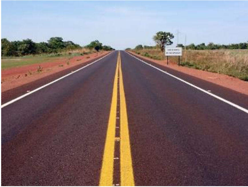
Figura 5 – Exemplo de um pavimento flexível em serviço (Bernardes, 2021)
