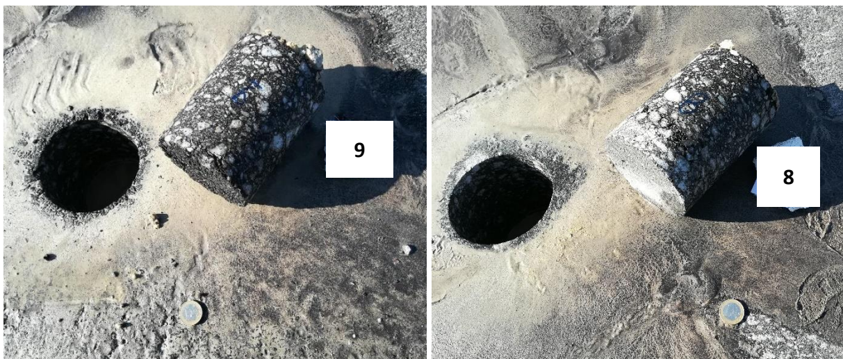
Figura 13 – Carotes extraídos da zona 1 (9) e da zona 2 (8) do pavimento na plataforma
