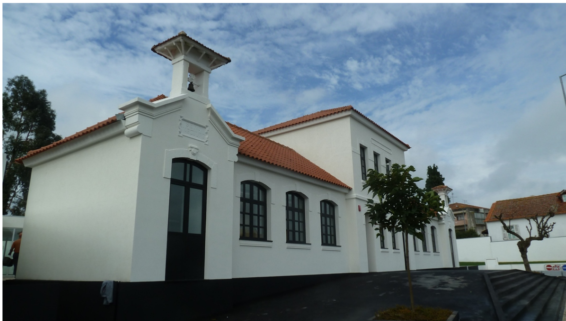
Figura 5 (Fachada da Academia de Música de São João da Madeira)
