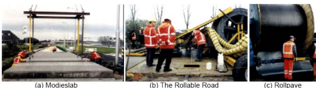
Figura 4.13 – Exemplos de superfícies de estrada modulares testadas durante o projecto holandês “Estradas para o Futuro” [FEHRL, 2006]
