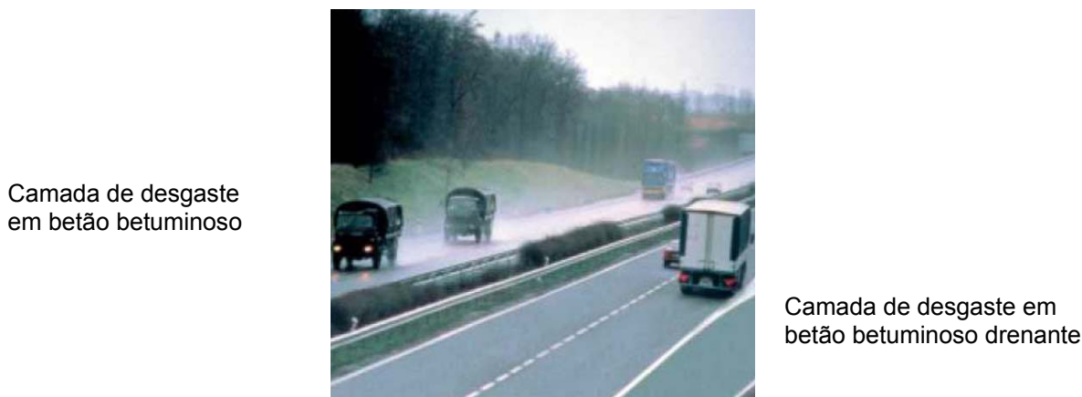
Figura 4.8 – Efeito de projecção de água numa camada betuminosa clássica vs. numa camada drenante [Bartolomaeus, 2006]
