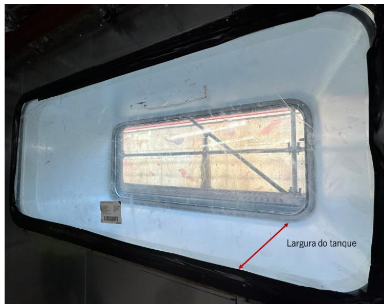
Figura 42: Estrutura da vigia das cabines de passageiros 109 a 112. A seta indica a largura do tanque que se encontra entre as duas anteparas de separação entre o espaço interior e o exterior.
