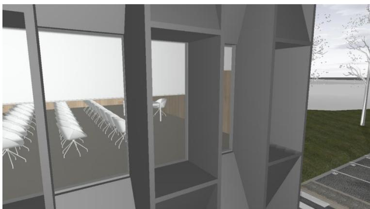
Figura 11 – Exemplo de palas horizontais e verticais.
