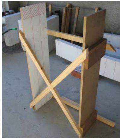
Figura 5.3 – Moldes de madeira utilizados na construção das paredes de alvenaria de três panos.
