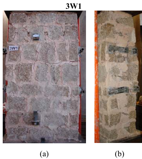
Figura C.7 – Padrão de fendilhação da parede 3W1 no final do ensaio: (a) face B; (b) face C.
