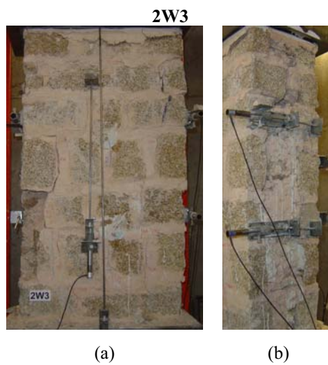
Figura C.5 – Padrão de fendilhação da parede 2W3 no final do ensaio: (a) face B; (b) face C.
