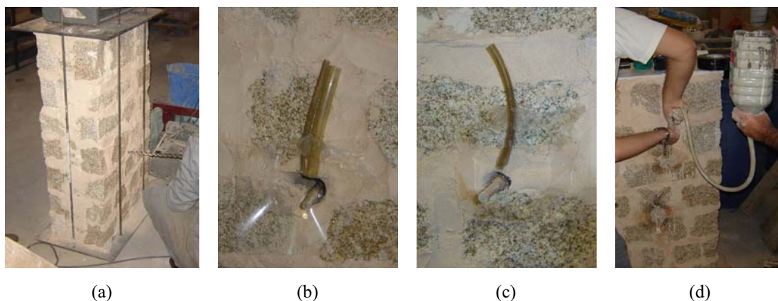
Figura 5.7 – Reforço das paredes de alvenaria de três panos com pregagens transversais: (a) execução dos furos para aplicação dos varões de GFRP; (b) pormenor da selagem do furo, do lado da injeção (tubo de injeção mais tubo de purga de ar); (c) pormenor da selagem do furo, do lado oposto ao da injeção (apenas um tubo de purga de ar); (d) injeção localizada por gravidade.
