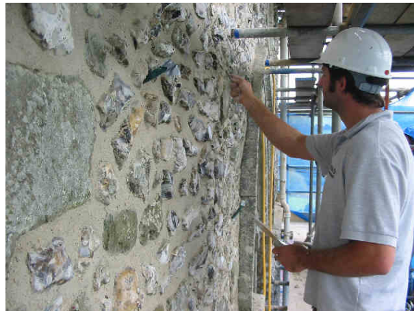
Figura 2.18 – Refechamento das juntas da torre da Igreja de Jevington (Reino Unido) com uma argamassa de cal ( in http://www.jevingtonchurch.co.uk ).
