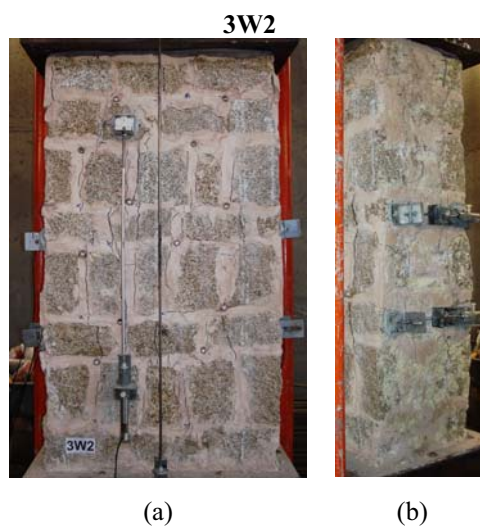
Figura C.8 – Padrão de fendilhação da parede 3W2 no final do ensaio: (a) face B; (b) face C.
