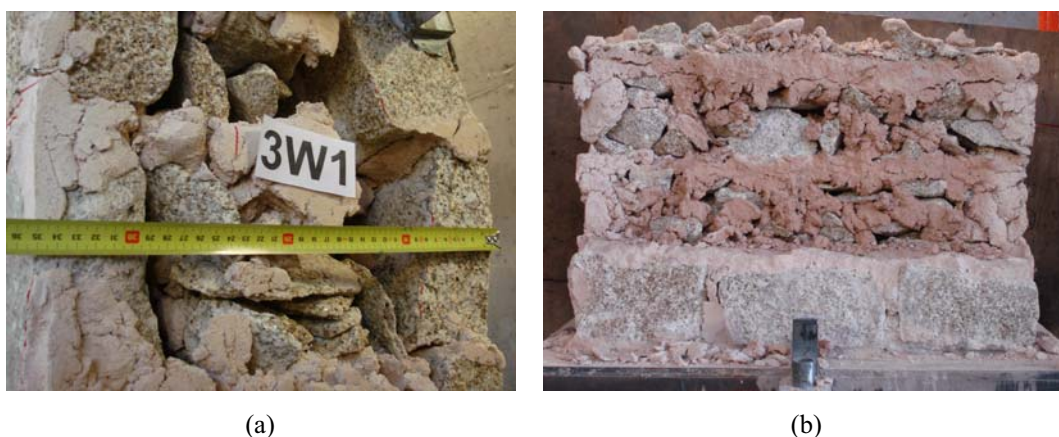
Figura 5.19 – Parede 3W1 no final do ensaio: a) separação dos panos externos; b) vazios do pano interno.
