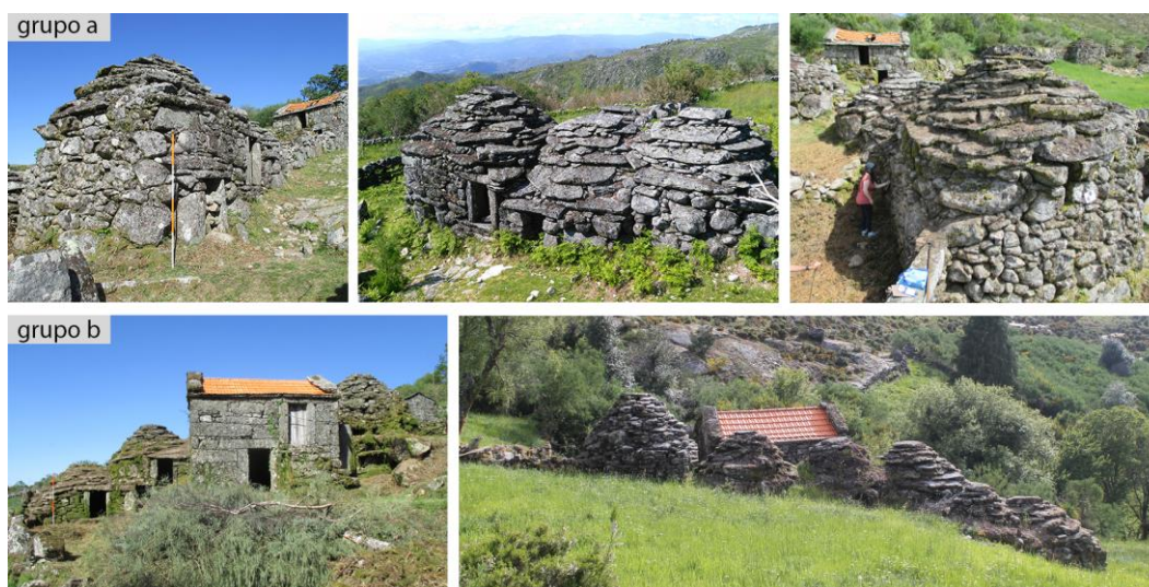
Figura 1: Grupos a e b) grupos de edifícios analisados em detalhe durante o trabalho de campo (“ branda ” da Gêmea, Padrão, Sistelo )
