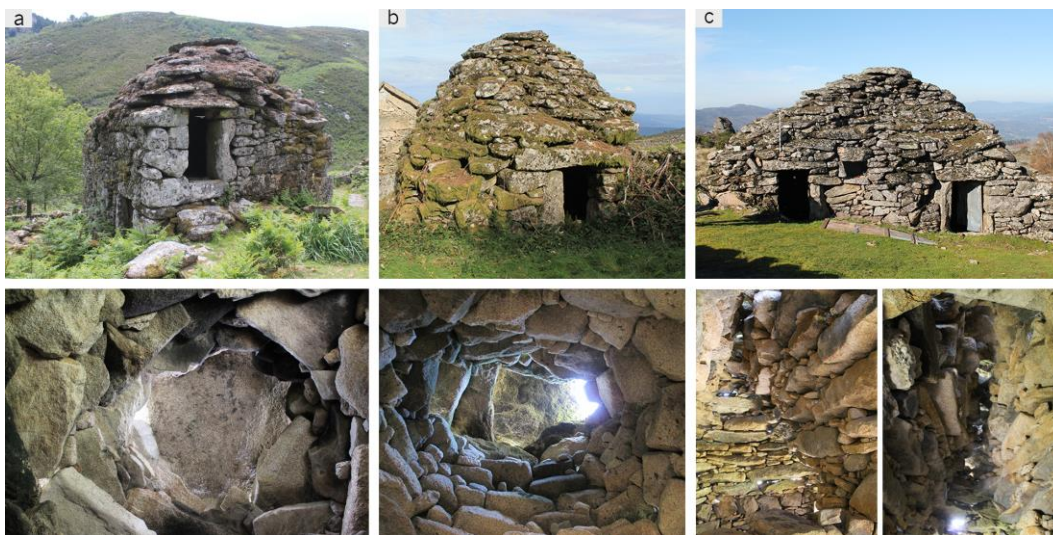
Figura 7: Exemplos de diferentes tipos de cúpulas: a) "abrigo" de 2 pisos com cúpula baixa; b) "abrigo" de 1 piso com cúpula alta; c) "abrigo" de 1 piso com falsa abóbada (Arcos de Valdevez) [3].
