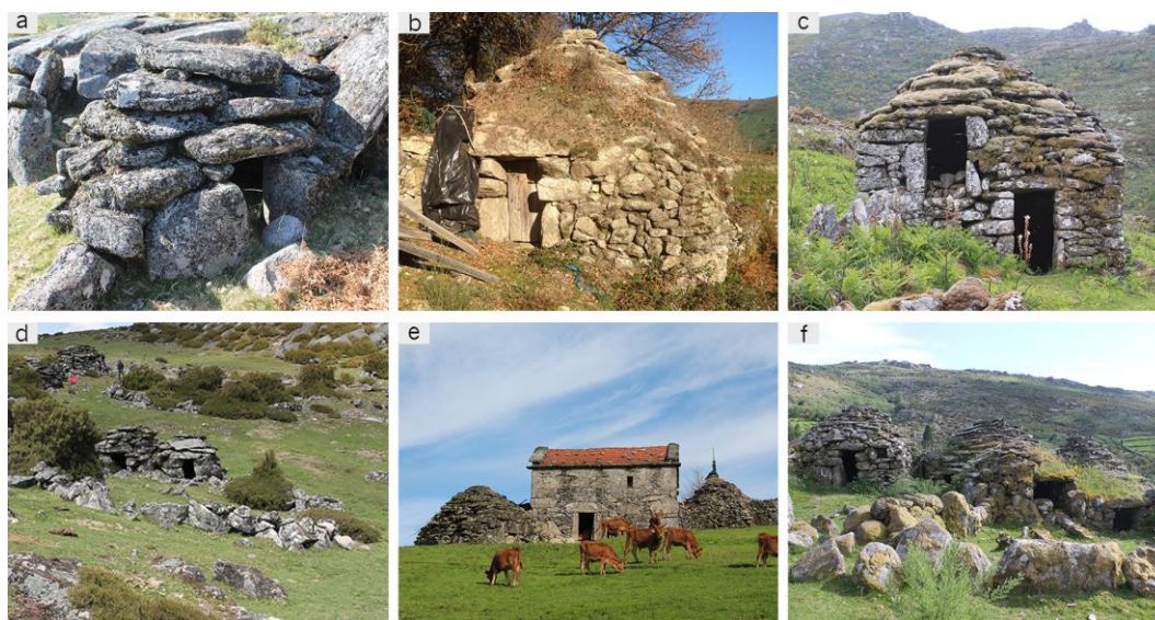
Figura 9: a) “ abrigos ” de gado (“ branda ” de Lamelas); b) “ abrigos ” de gado com cobertura de terra ( Soajo ); c) “ abrigo ” de agricultores/pastores (“ branda ” de Burzavô); d) grupo simples (“ branda ” da Seida); e) grupo composto com “ casa de branda ” (“ branda ” do Alhal); f) grupo complexo (“ branda ” da Gêmea).
