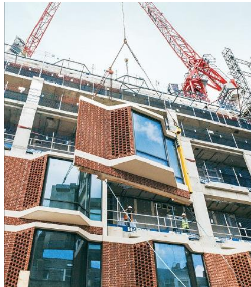
Figura 26 - Construção modular
