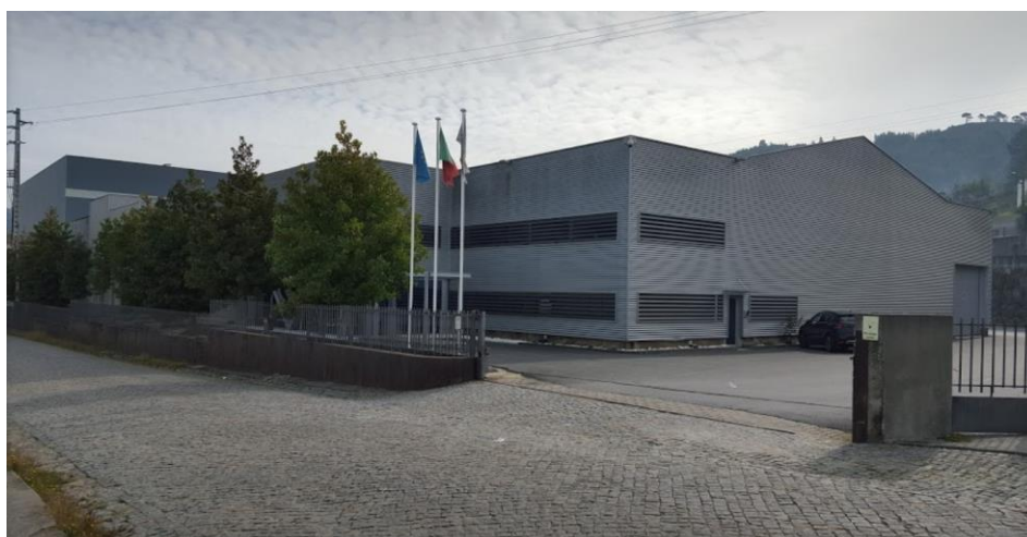
Figura 18 – Instalações da Vizelpas
