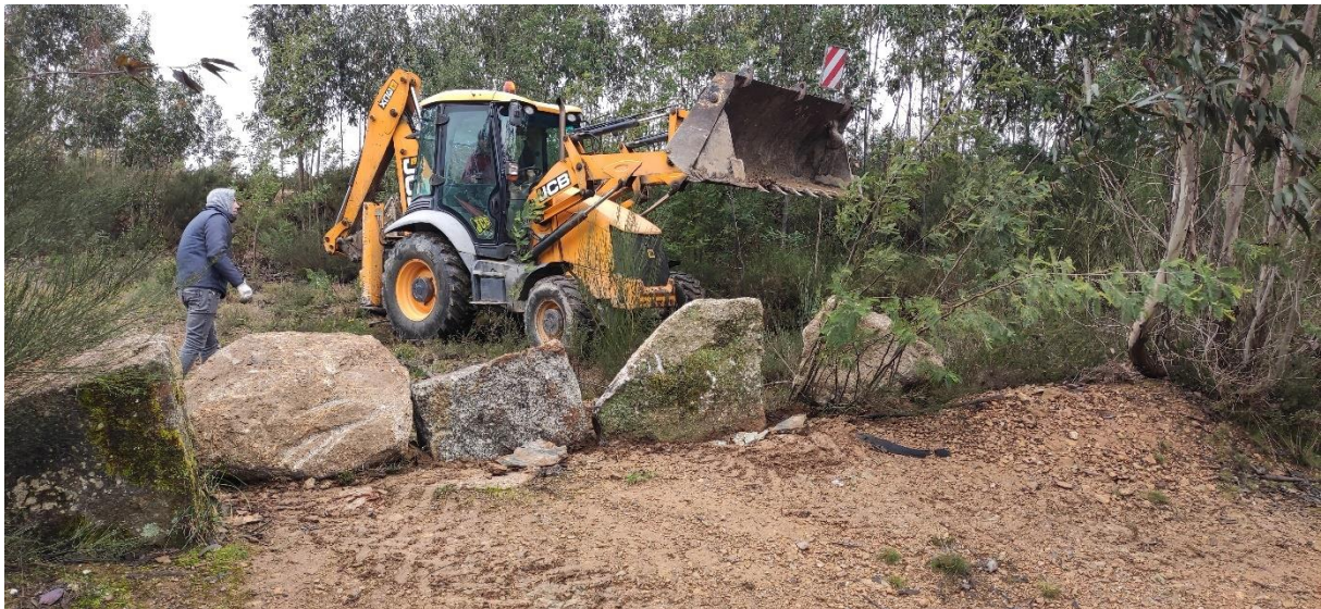
Figura 27 - Acompanhamento dos trabalhos de colocação de blocos pétreos de grande porte para bloqueio da passagem de veículos para os monumentos megalíticos e de tradição megalítica (autor).
