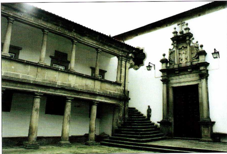
Fig. 28 Fachada do «Hospital da Casa», pátio e pòrtico lateral da igreja
