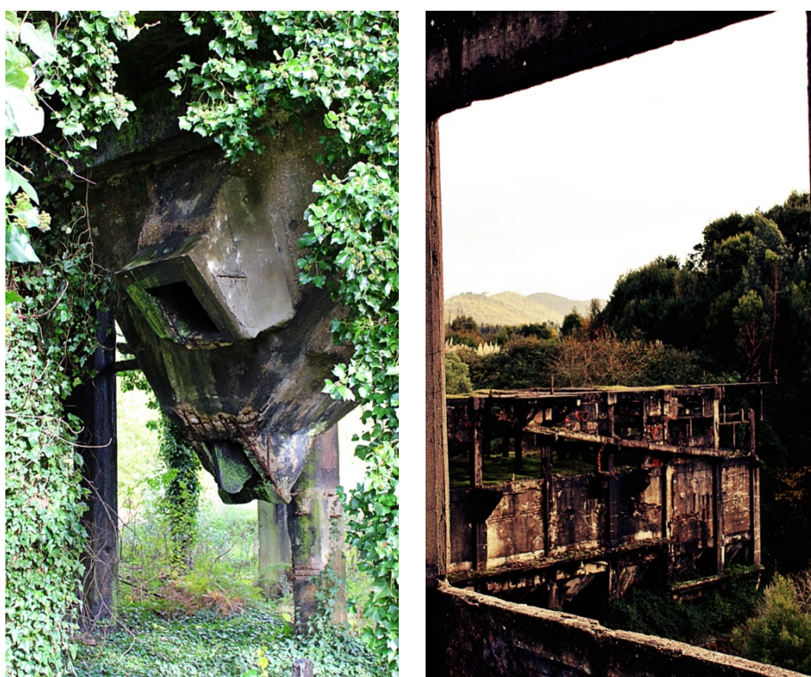
figura 52_ Parte inferior de depósitos de carvão, por onde saia o carvão para britar e carregar as berlinas; ruínas do armazém de depósito de carvão, respetivamente, fotografias de Pedro Paiva. 2018.
