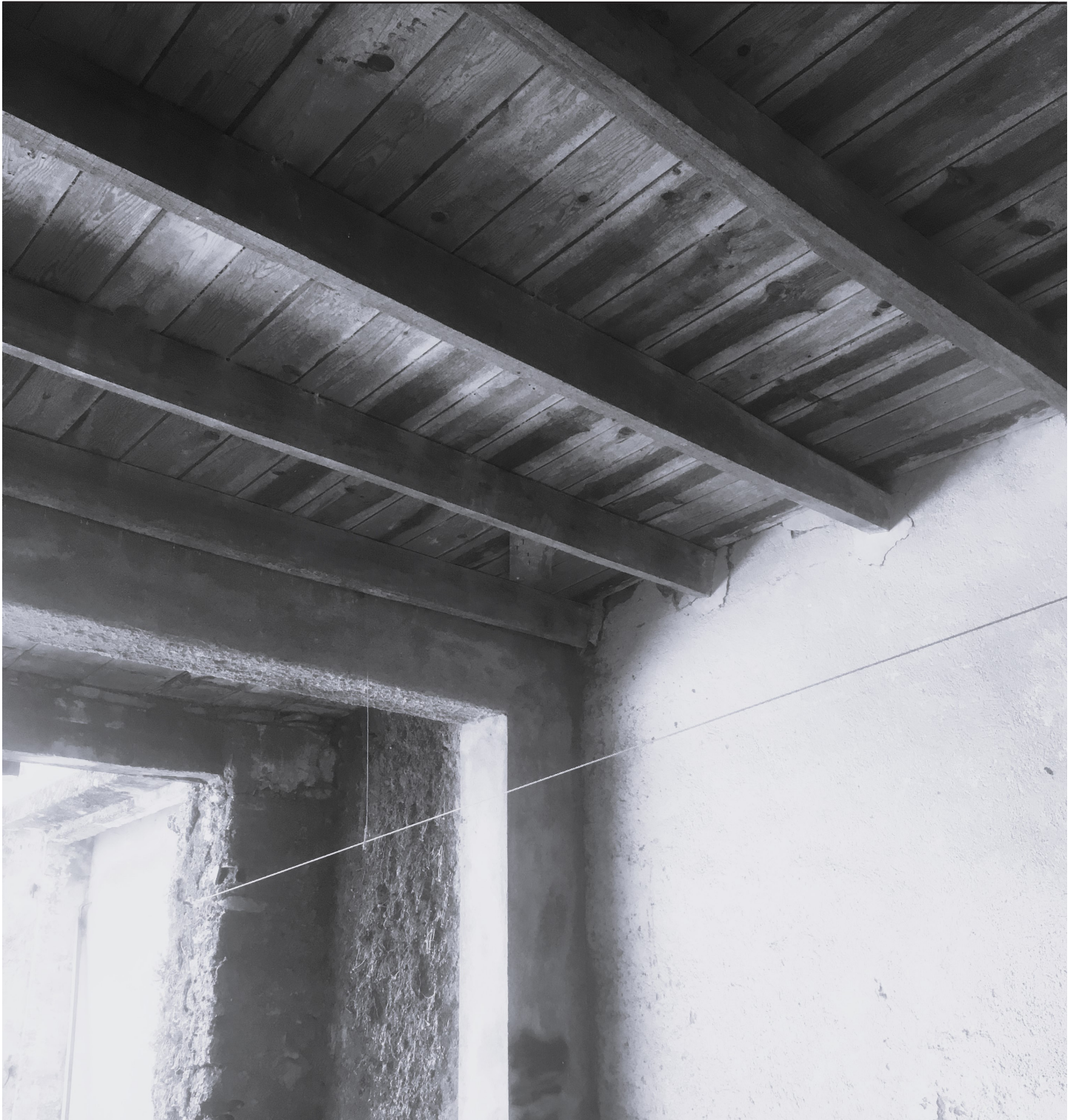
42. Fotografia Própria, Detalhe de Construção | 2023
