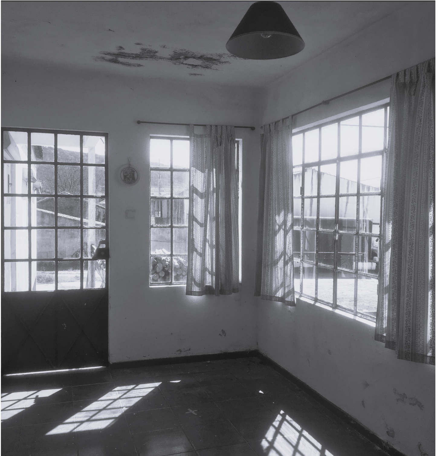
44. Fotografia Própria, Marquise (vista interior) | 2023
