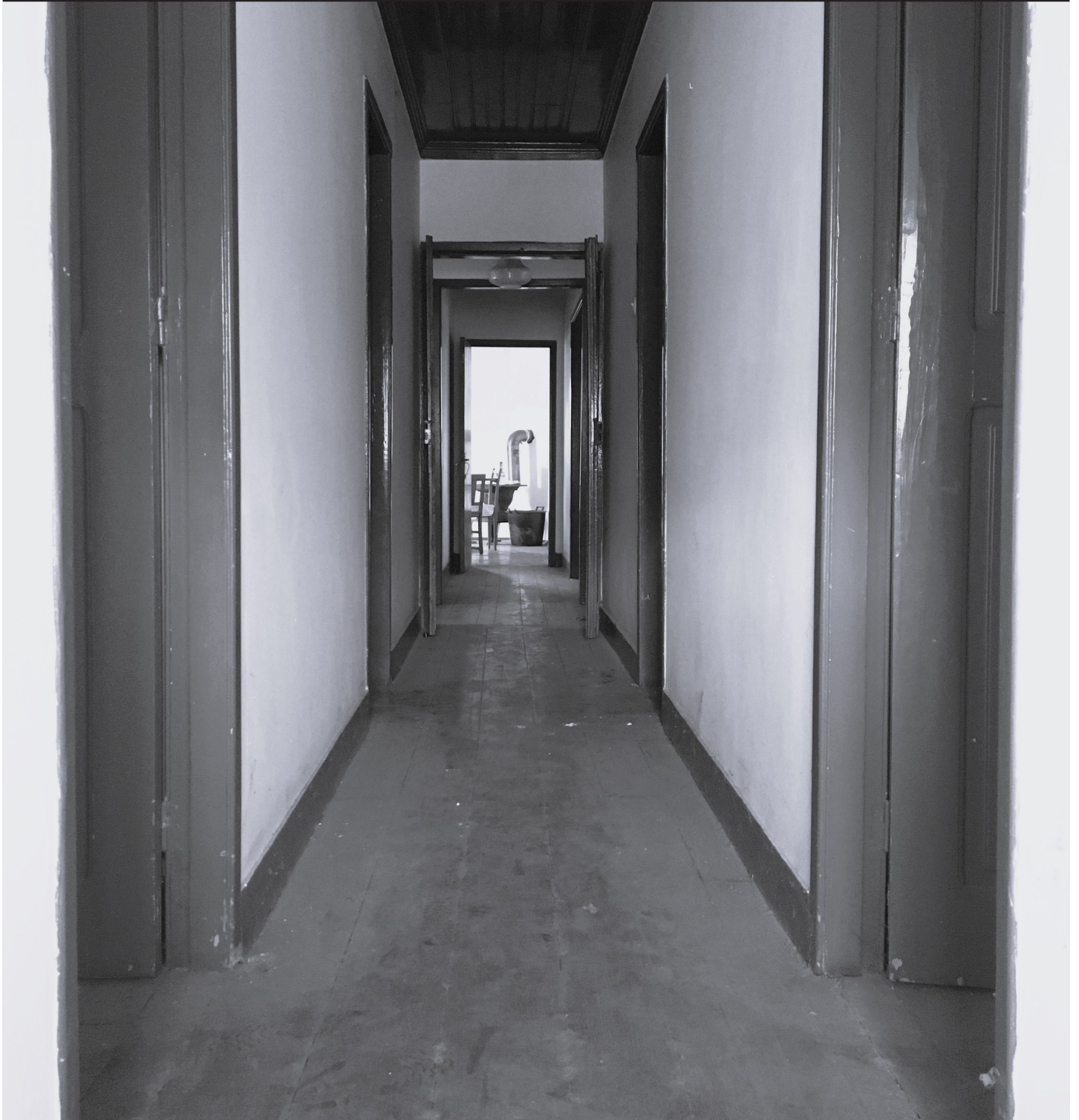
10. Fotografia Própria, Corredor vista norte | 2022
