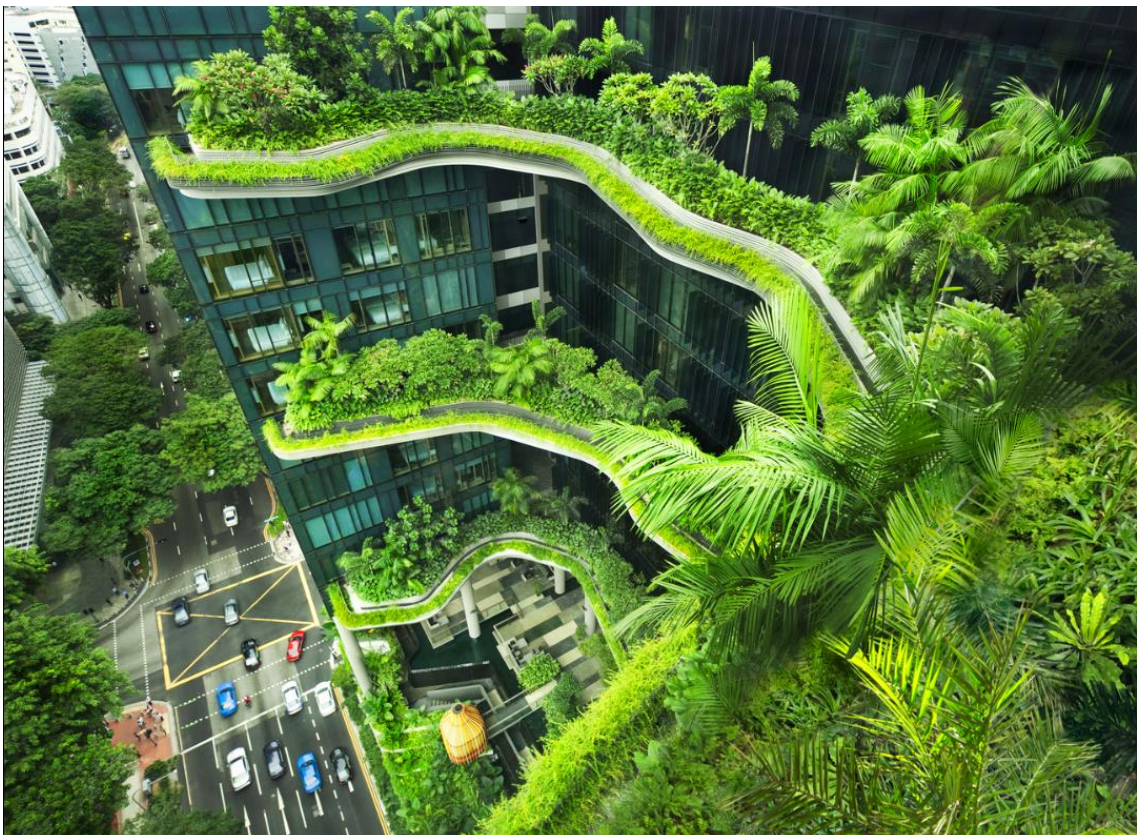
Fig. 52 Fotografia do projeto Parkroyal Collection Pickering disponibilizada pelo atelier WOHA que mostra a vegetação tropical e quantidade da mesma disposta por vários níveis do edifício.
