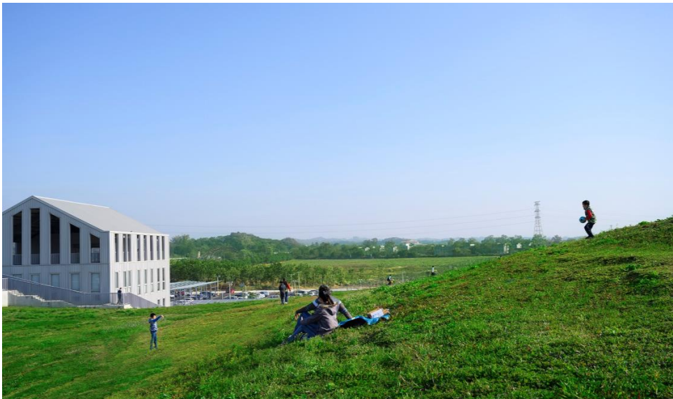
Fig. 24 Fotografia do exterior do projeto Taiwan Market disponibilizada pelo atelier MVRDV que mostra a conexão visual entre o projeto e as colinas da paisagem de Taiwan
