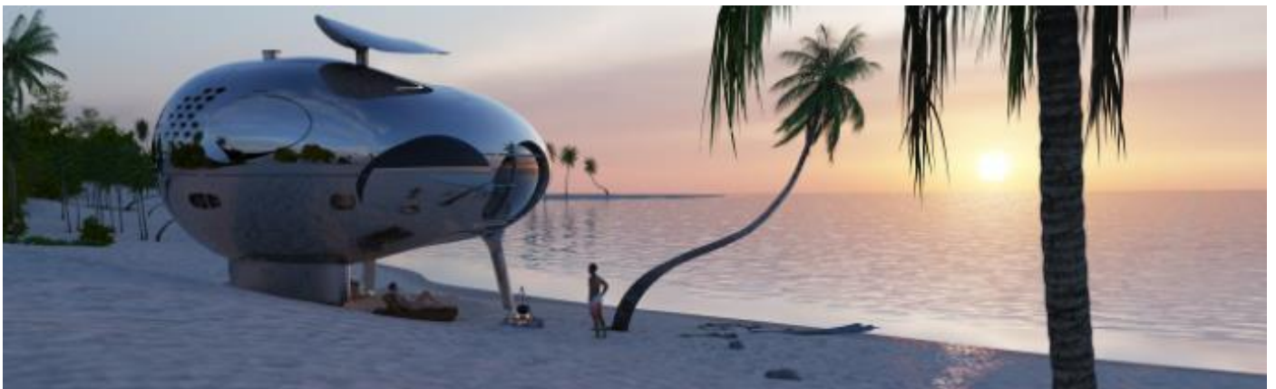
Fig. 20 Render do projeto SuperChalet em Realidade Virtual publicado pelo grupo Zaha Hadid Architects Virtual Reality
