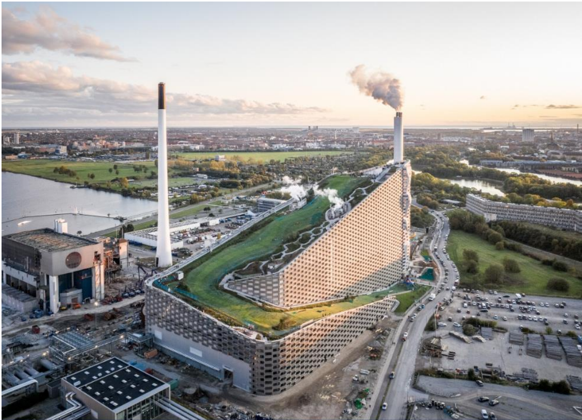
Fig. 16 Fotografia aérea do projeto CopenHill atualmente, fotografada por Rasmus Hjortshøj
