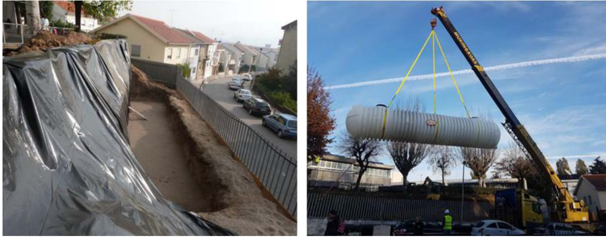
Figura 23 - 1ª fase - escavação e colocação do reservatório Fonte: Machado (2019b)
