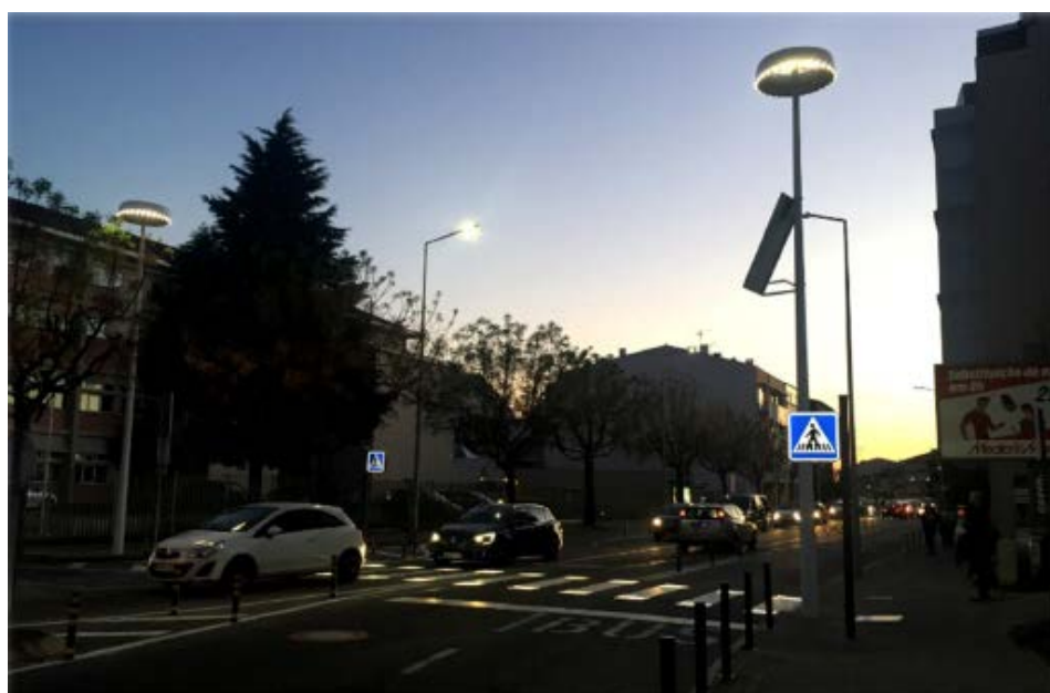
Figura 19 - Passadeira após a intervenção: sinais verticais retroiluminados, iluminação de solo e Omniflow (entardecer) Fonte: Câmara Municipal de Braga
