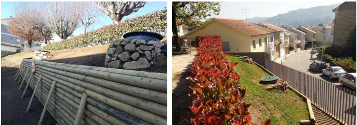
Figura 25 - 3ª fase - finalização da instalação do reservatório Fonte: Machado (2019b)
