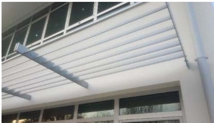
Figura 22 - Edifício do 1º ciclo da Escola Básica das Enguardas - após o revestimento térmico e sombreamento - BUILD Fonte: Machado (2019a)
