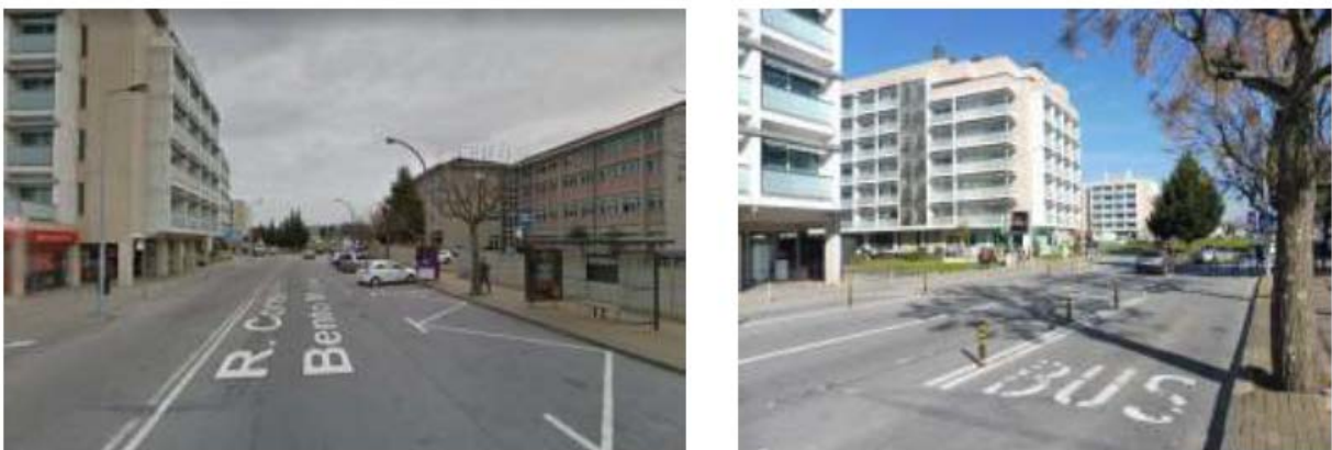
Figura 14 - Antes e depois da implementação da Faixa Bus Fonte: Souza (2019)
