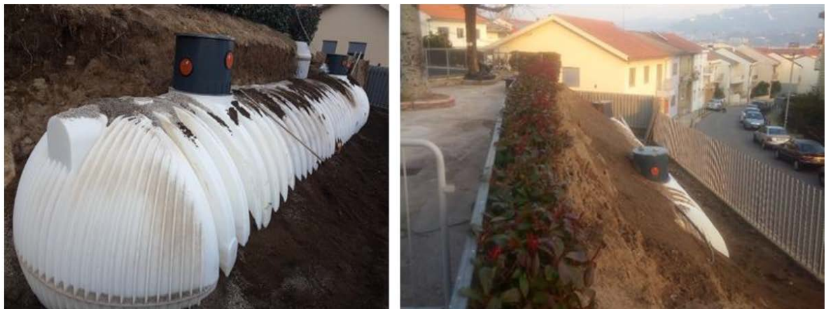
Figura 24 - 2ª fase - instalação do reservatório Fonte: Machado (2019b)
