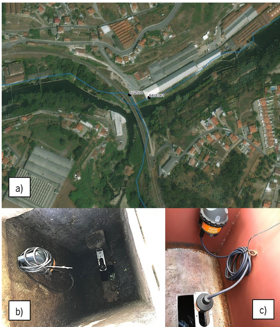
Figura 11 – Localização de sensores intermédios do sistema interceptor: a) Planta de localização; b) Sensor 6AVE061; e c) Sensor 6VIZ004.
