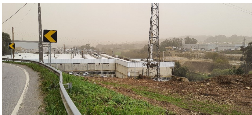
Vista da Rodovia N206 na altura de Ronfe
