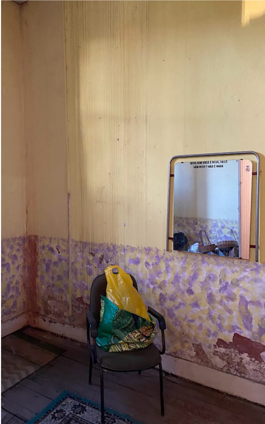
Fig. 83 - Pintura em casa 5.
