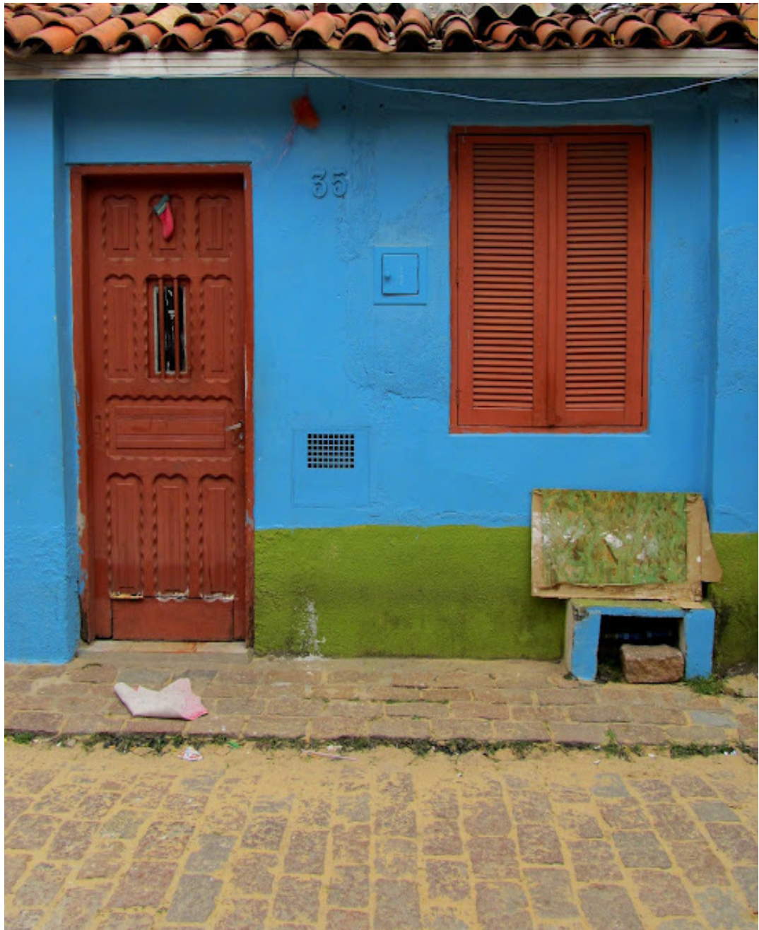
Fig. 64 - Vila Industrial. Alçado de antiga casa operária
