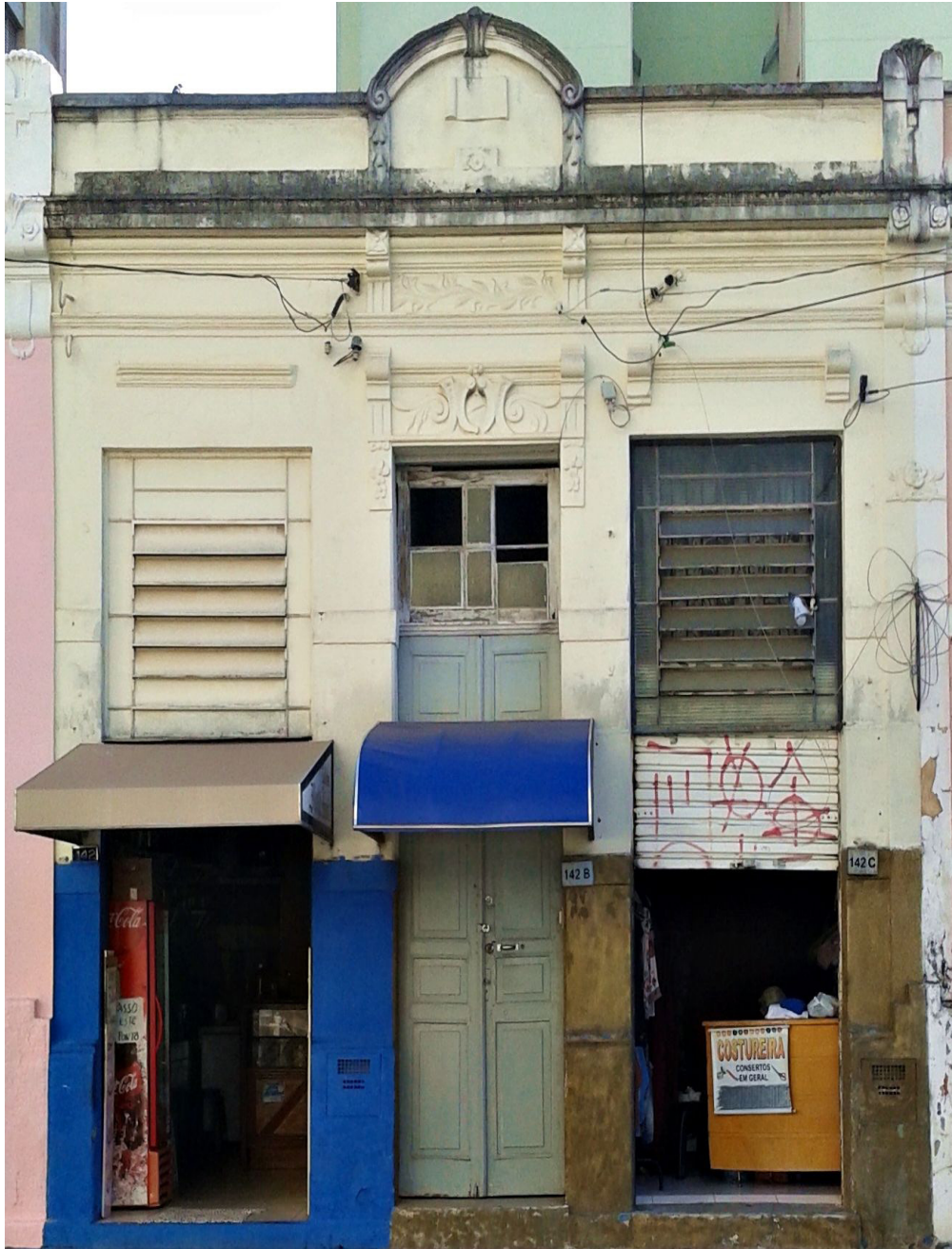
Fig. 65 - Vila Industrial. Tratamento e diferenciação dos alçados.
