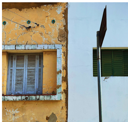
Fig. 43 - Vila Industrial. Diferenciação dos alçados
