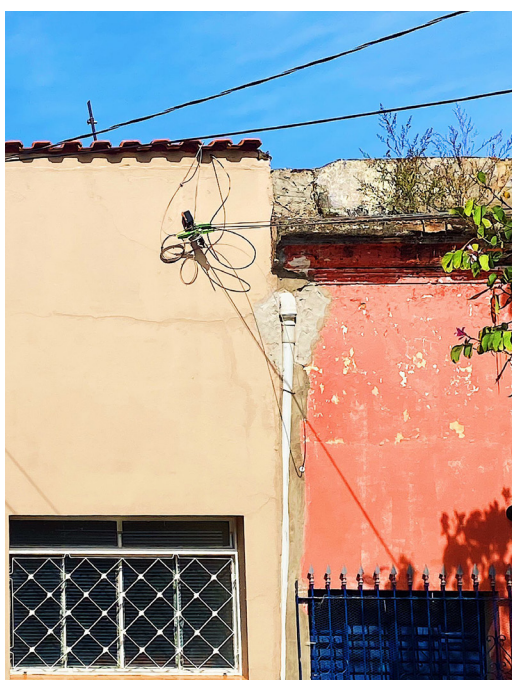
Fig. 44 - Vila Industrial. Diferenciação dos alçados
