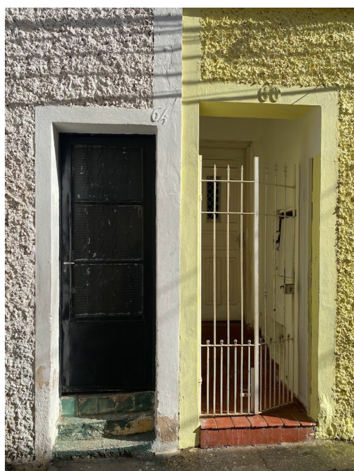
Fig. 45 - Vila Industrial. Diferenciação dos alçados
