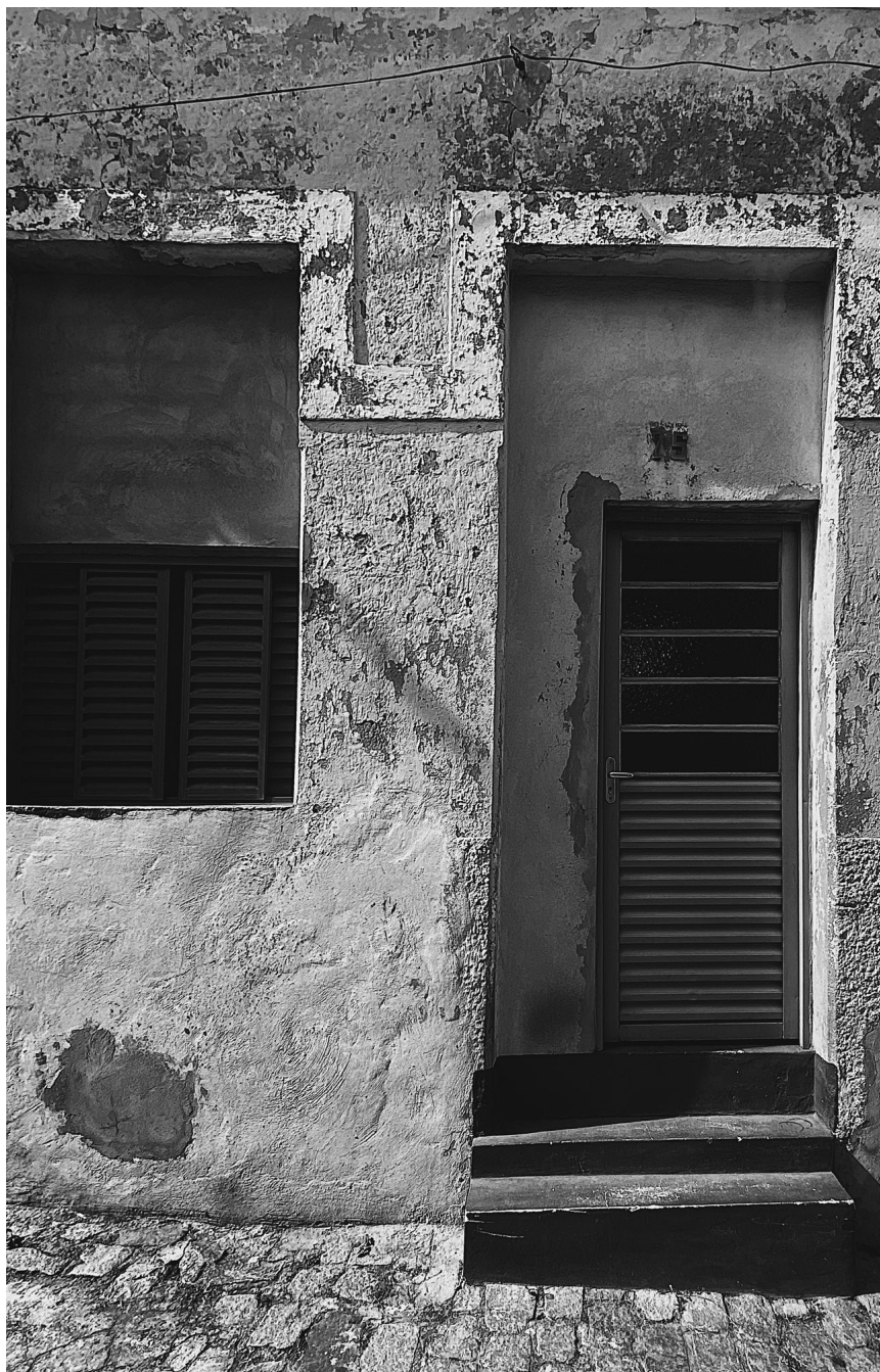
Fig. 62 - Vila Industrial. Alçado de casa com marcas do passado.
