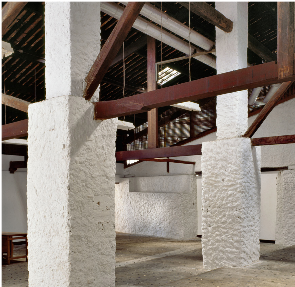
Fig. 22 - Solar do Unhão. Estrutura.
