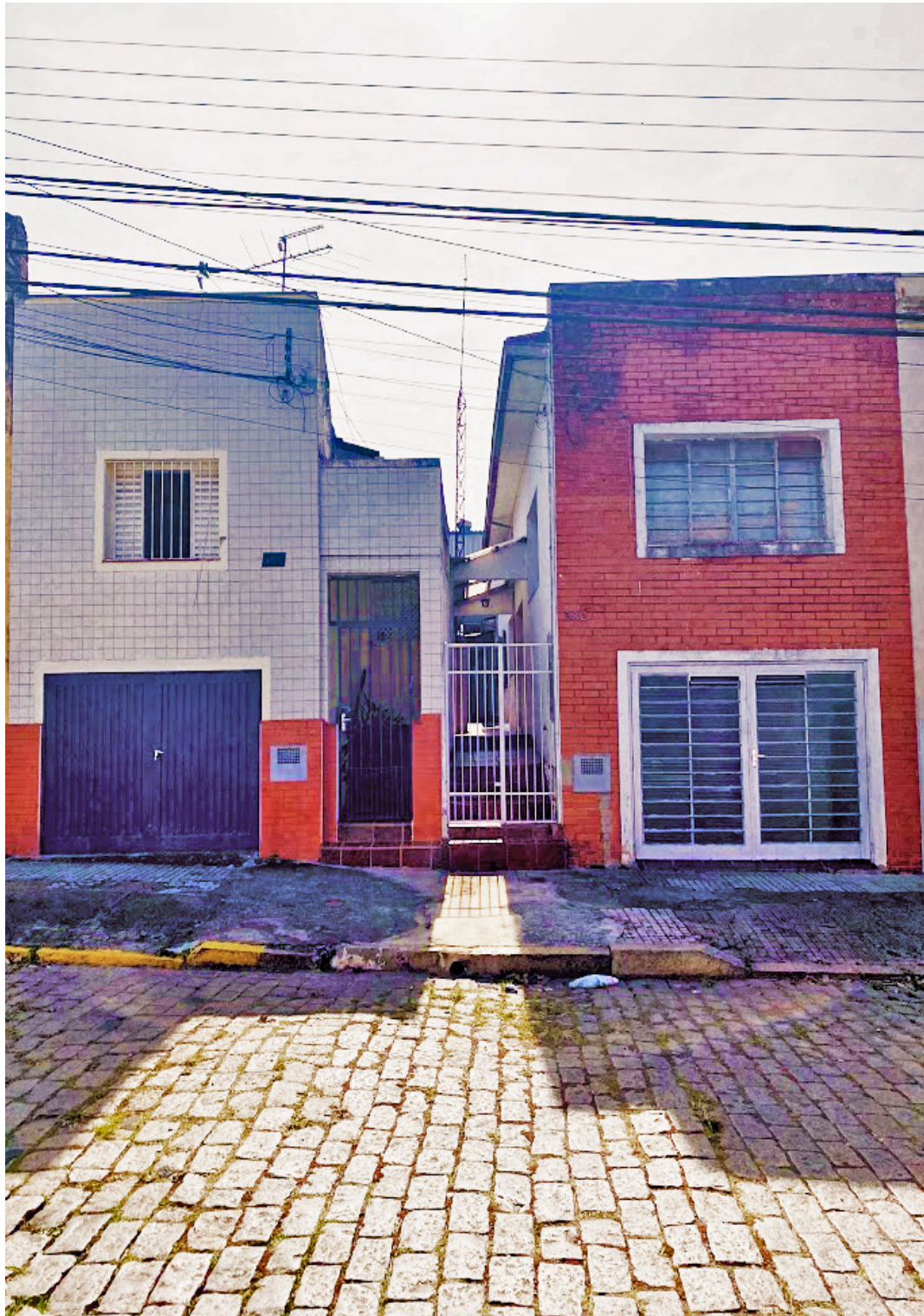
Fig. 67 - Vila Industrial. Alçados em casas geminadas
