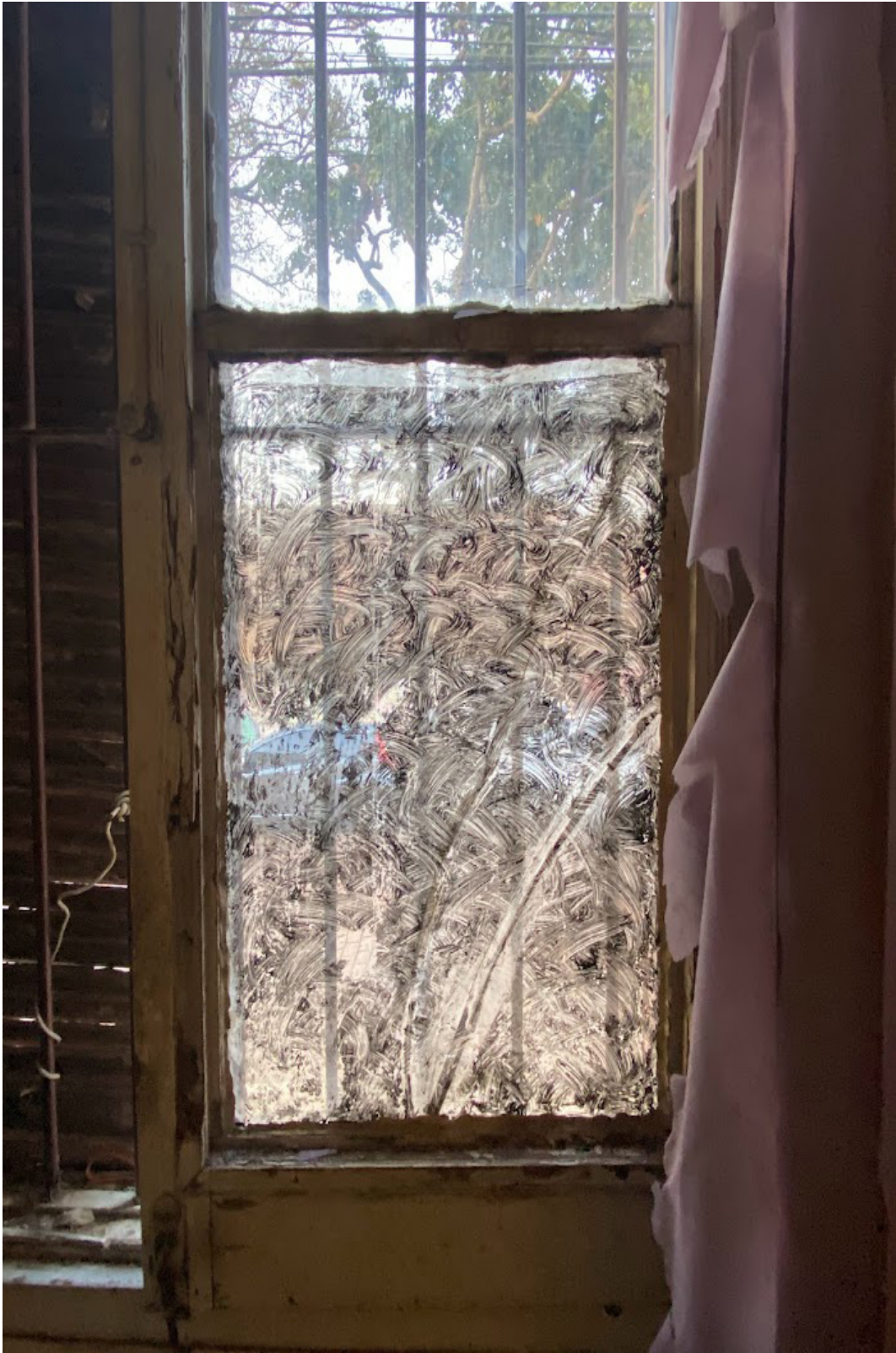
Fig. 78 - Janela estilizada, casa 5.
