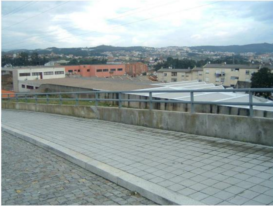
Figura 6 - Muro de guarda para veiculos (Parente Lima, 2006).
