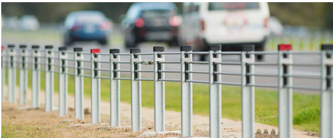
Figura 9 – Barreira de segurança flexível com 4 cabos (Carportal, n.d.)
